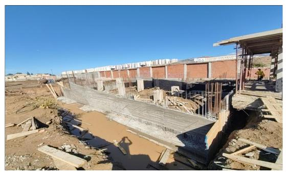
Figure 26 : Pouring the wall and the anchor columns for the Amphitheatre block Source: « DIB SALAH « company
