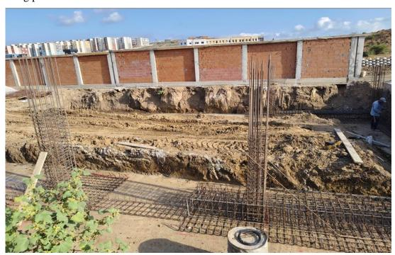
Figure 25 : Reinforce the foundations of the Amphitheatre block Source: « DIB SALAH « company
