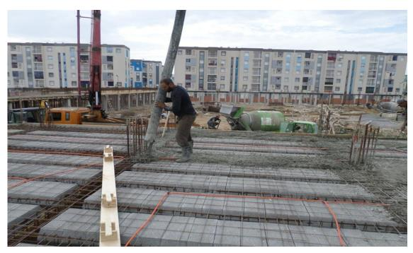
Figure 30 : Pouring floor NIV 3.40 joint 02 Source: « DIB SALAH « company
