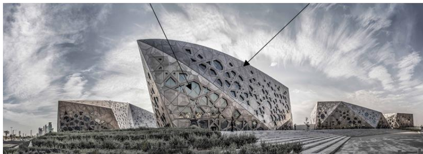
Figure 54 : façade du projet
