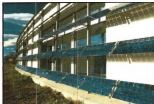
Figure 24 : protections solaires mobiles Source : Boursas Abderrahmane, 2012-2013
