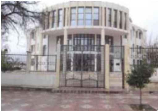
Figure 62 : façade du projet
