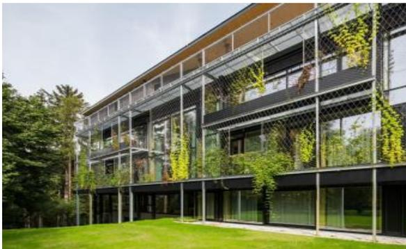
Figure N°241 : IGF sur treillis bidimensionnel
