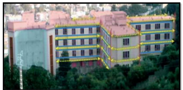
Figure II 21 : façade du CHU de Saintonge
