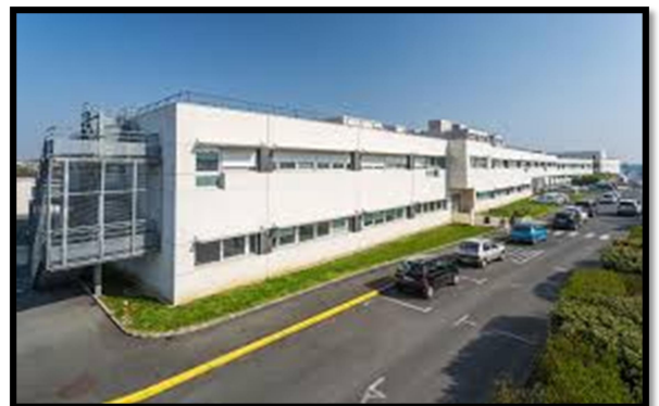
Figure II 13 : Façade du CHU de Saintonge
