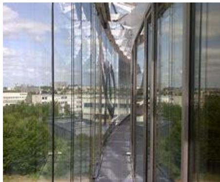
**Figure II.8:** Un canal de façade double peau
