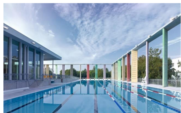
Figure 39 : Bassin sportif extérieur
