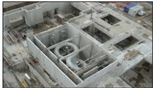
Figure 52 : les bains des docks entrain de construction
