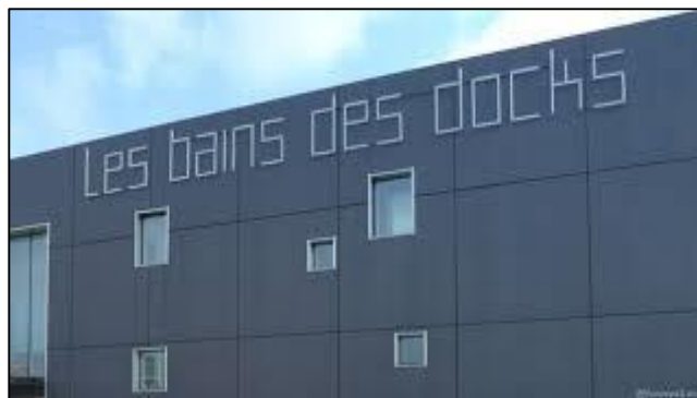
Figure 53 : le traitement de façade
