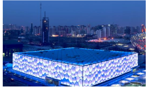
Figure 58 : le centre aquatique le Cube d'eau
