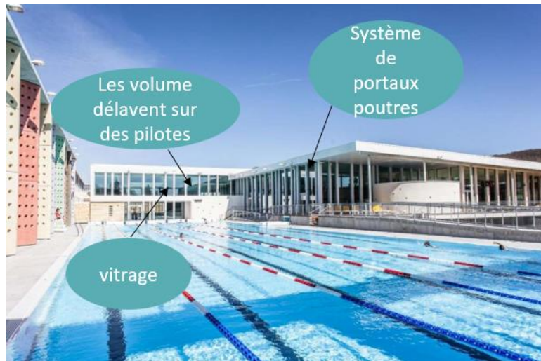
Figure 36 : Le système constructif.
