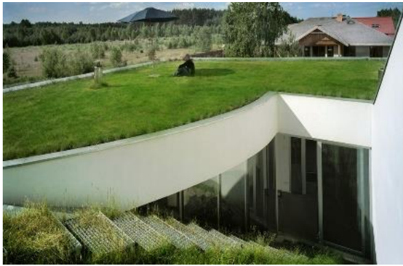
Figure 7 : la toiture intensive
