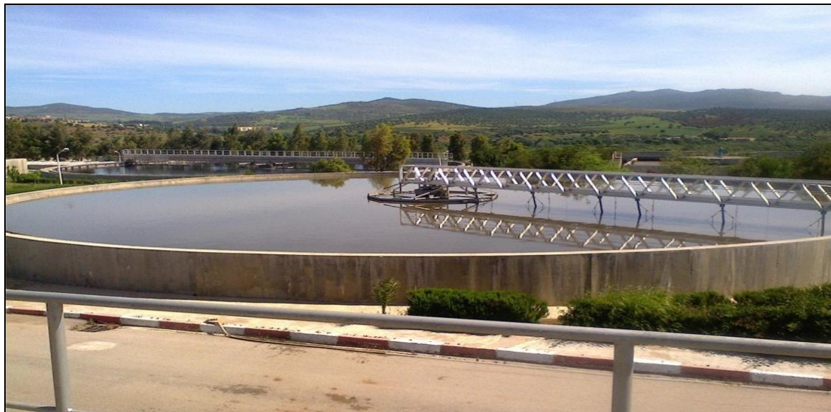
Figure 12 : Décanteur primaire (Photo prise par Taleb).
