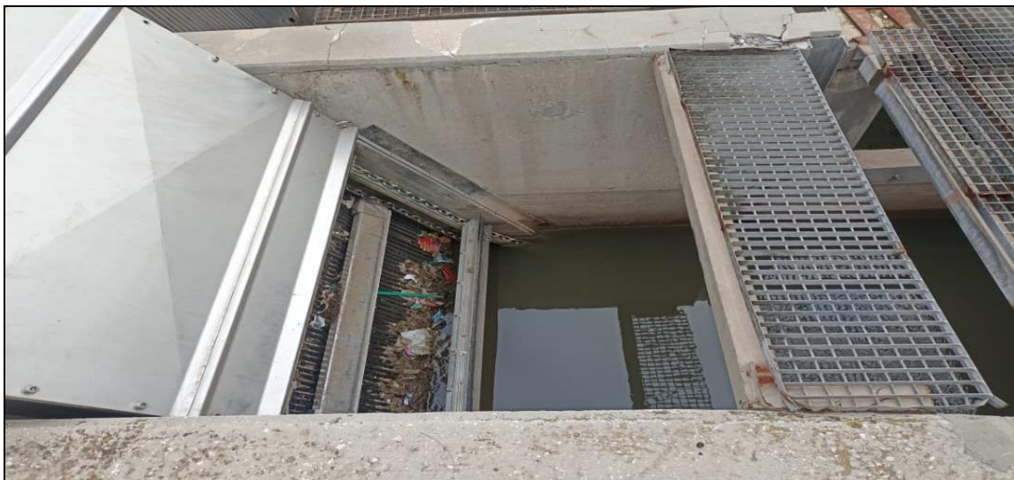
Figure 10 : Un dégrilleur (Photo prise par Guerfa).
