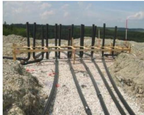
**Figure.6.** Collecte du biogaz (drains horizontaux)
