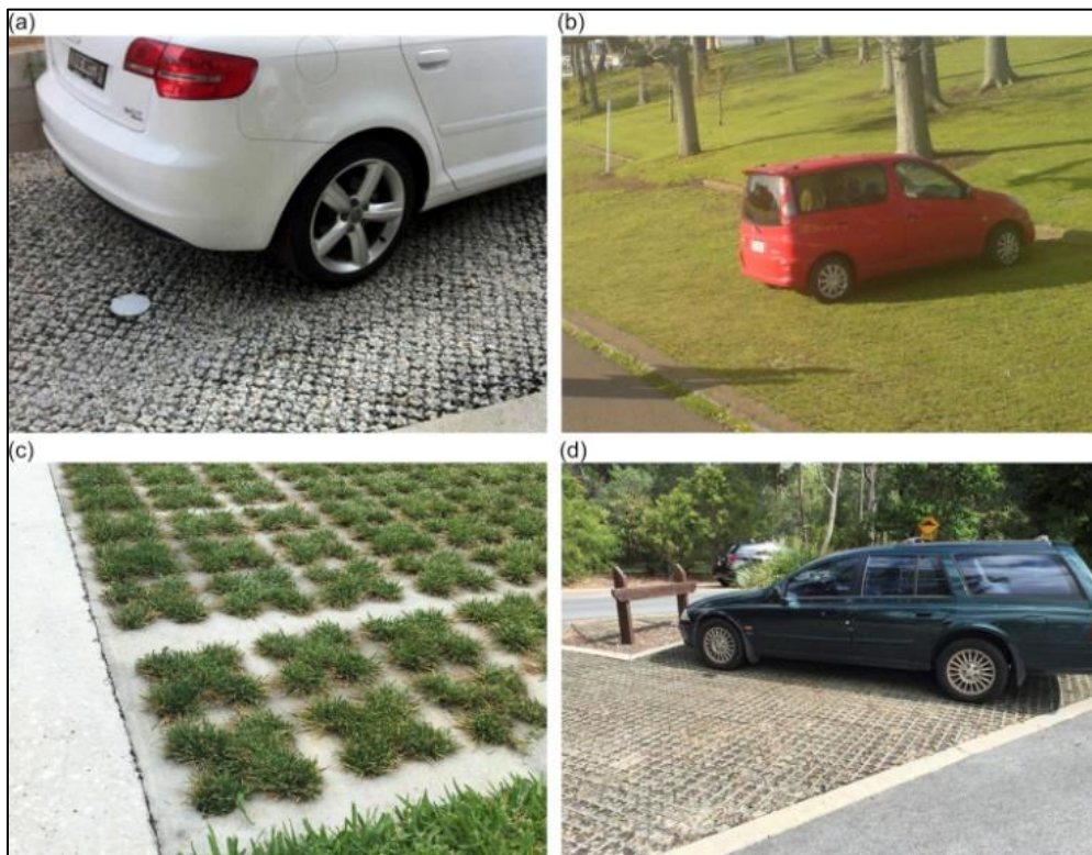
Figure II-16 : systèmes de chaussée perméables (pavés en béton perméables, systèmes de chaussée en grille (Hoban, 2019).
