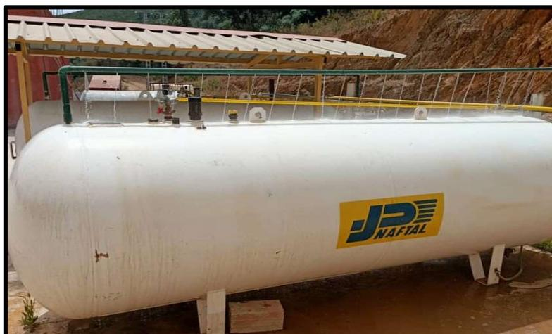
**Figure 18 : Réservoir de gaz propane. (Imad 2024)**
