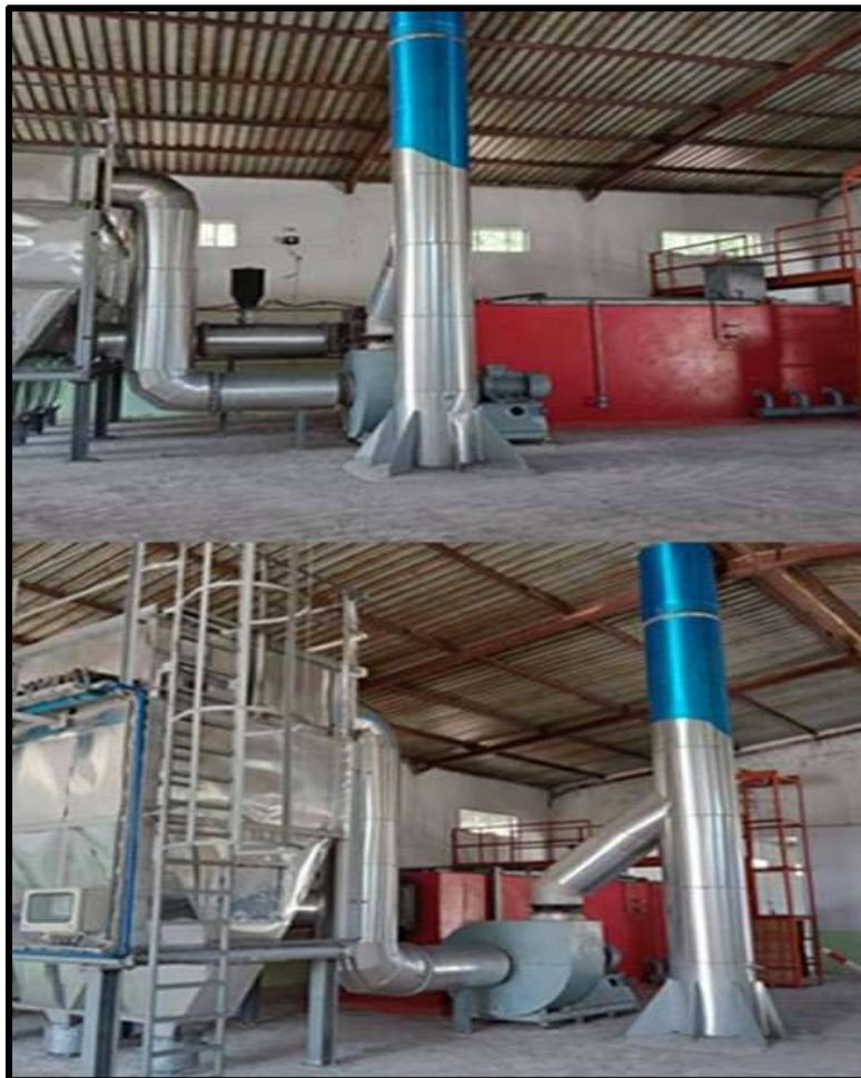
Figure 20 : L'alimentation des tubes et filtres pour la filtration des fumés. (Imad 2024)
