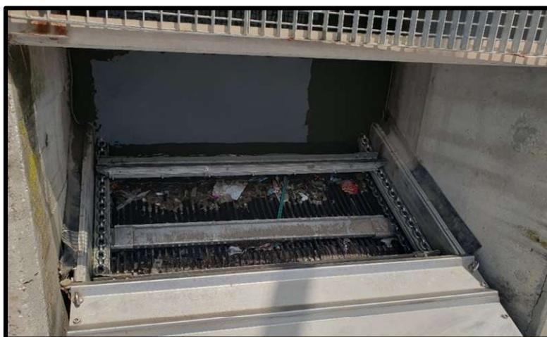
**Photographie 15 : Le dégrillage des déchets est effectué à l'arrivée à la station d'épuration. (Saidi 2024)**
