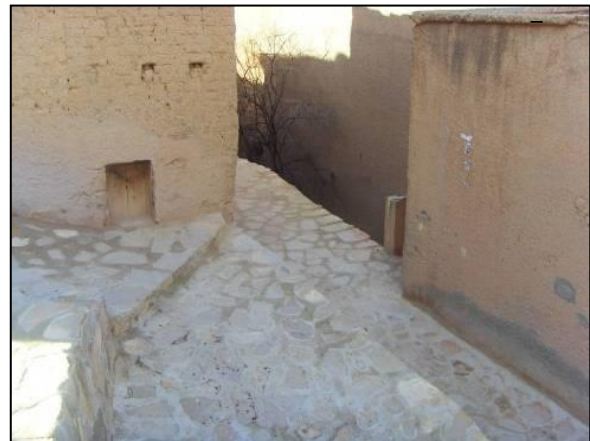
Photos (17) : Revêtement du sol de la Dechra (Pistes)
