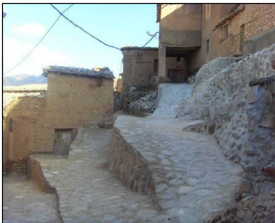
Photos (16) : Revêtement du sol du village et éclairage public
