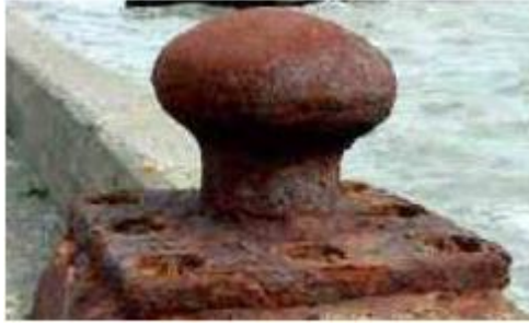
Figure I.1: Corrosion uniforme d'une pièce métallique.
