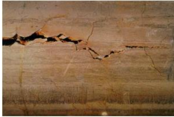
Figure I.8: corrosion sous contrainte d'un tube en acier inoxydable en présence de quelques ppm de chlorures.
