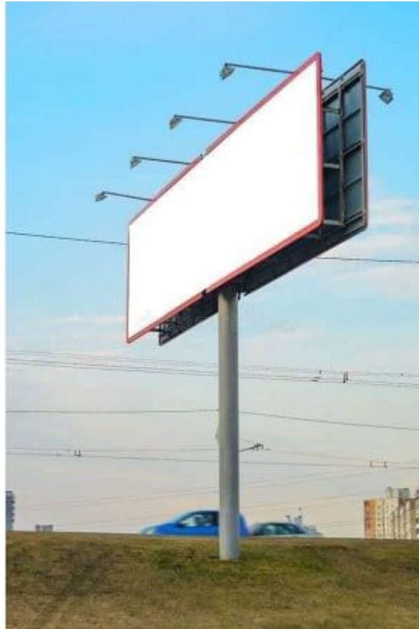
Figure II1: Panneau publicitaire en charpente métallique
