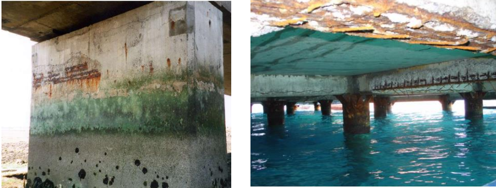
Figure I.18: Action des chlorures apportés par l'eau de mer [29].
