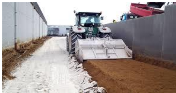
Figure II.9 Stabilisation des sols par la chaux [39]
