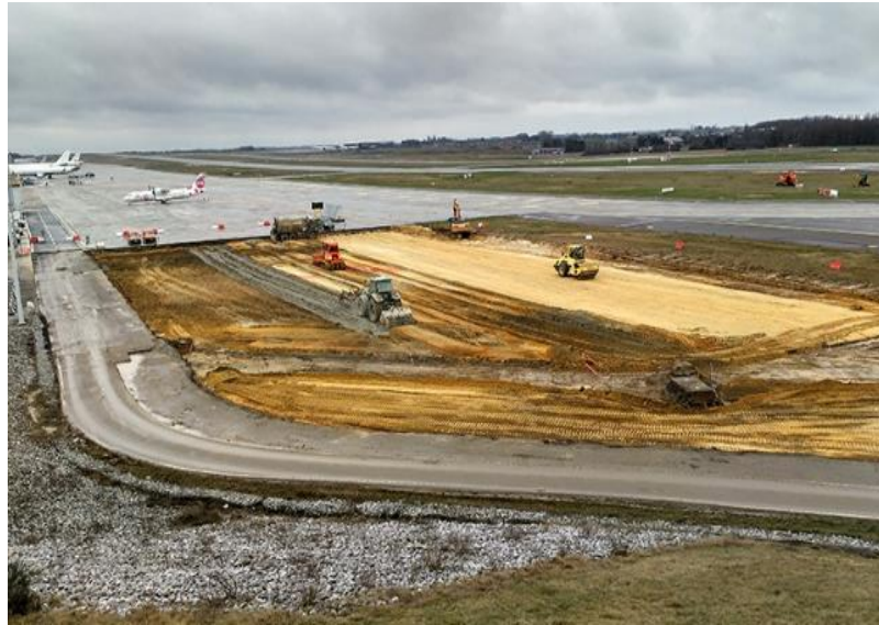
Figure II.8 Stabilisation des sols par le ciment [38]
