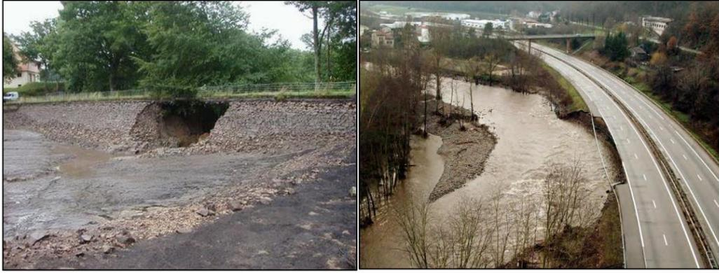
**Figure I. 15:** Phénomène d'érosion dans les remblais routiers
