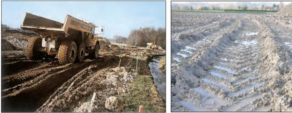
Figure I. 11 : Difficulté de la traficabilité des engins sur les sols fins
