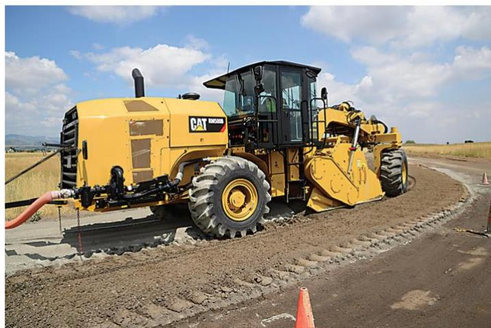
**Figure II. 19** : Malaxage du liant avec le sol avec pulvimalaxeur
