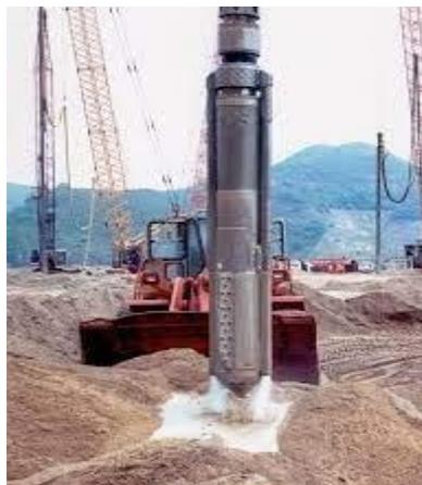
**Figure .II.4.Vibration profondes.**
