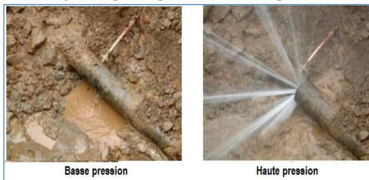
Figure 3.12 : Débit du même percé, à basse et à haute pression.
