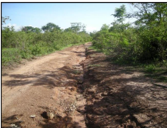
Figure I.10. Phénomène d'érosion dans la zone de plateau
