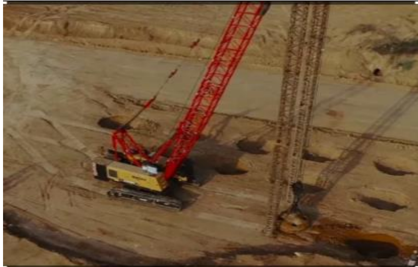
Figure II.2. Compactage dynamique.
