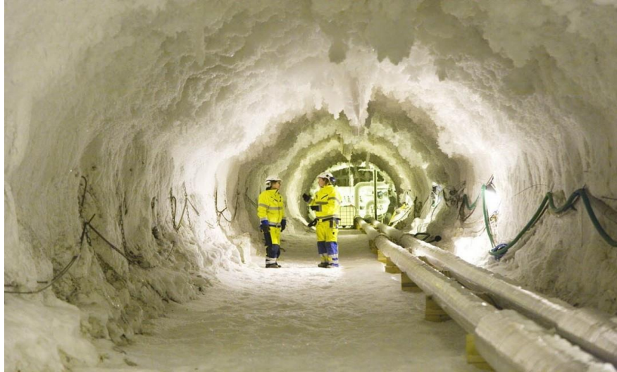
Figure II.11. Travaux en souterrain : la congélation des sols.
