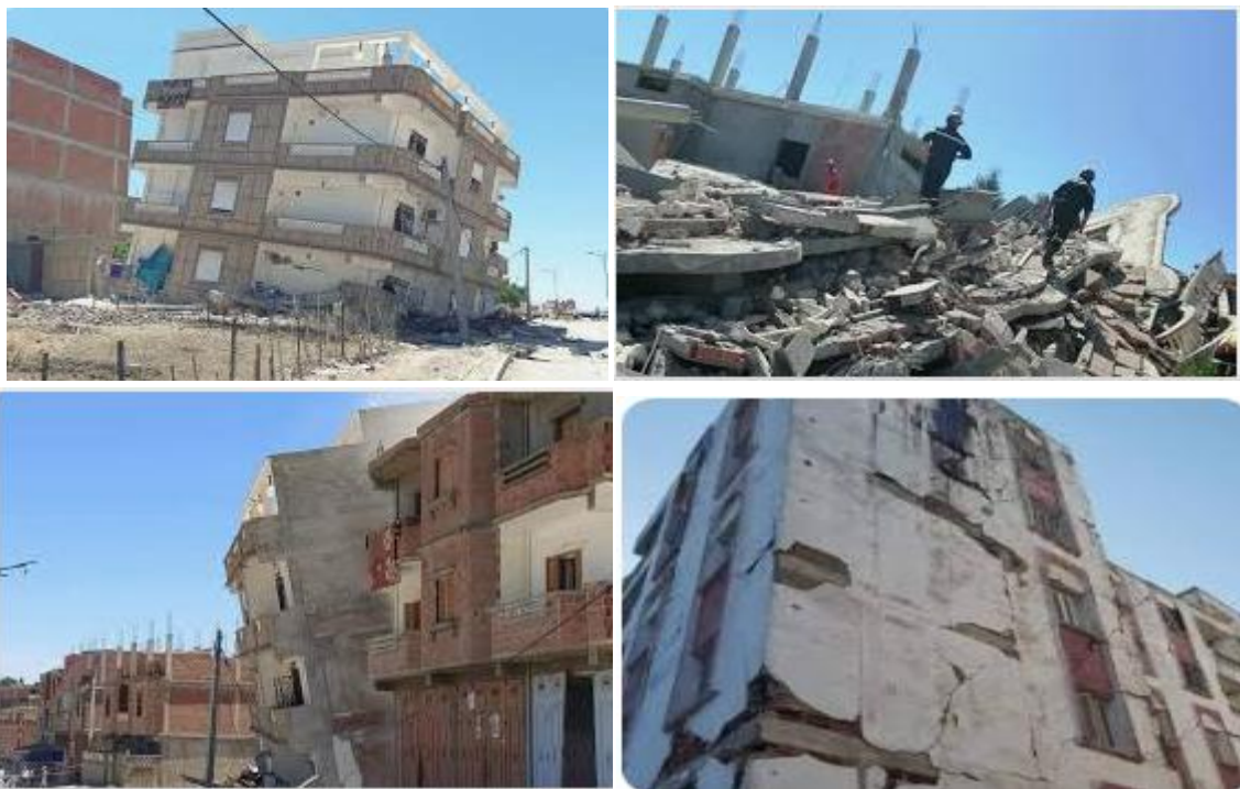
Figure III.1. Les dommages engendrés par le séisme du 7 août 2020.
