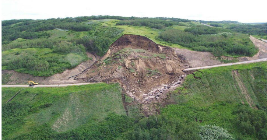
Figure I.13. Phénomène de glissement de talus naturel
