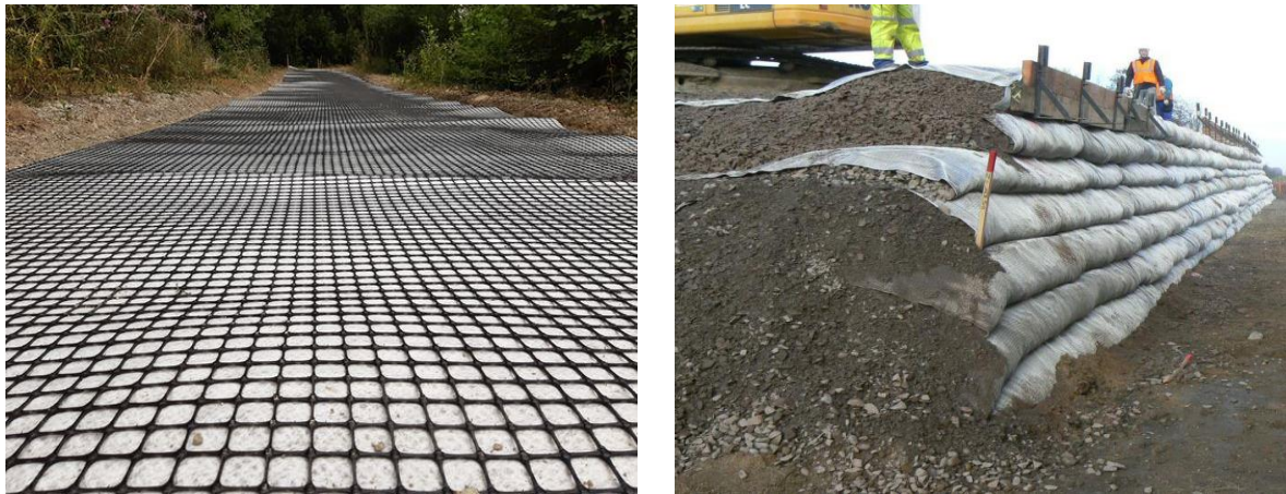
Figure II.9. Renforcement par géosynthétiques.
