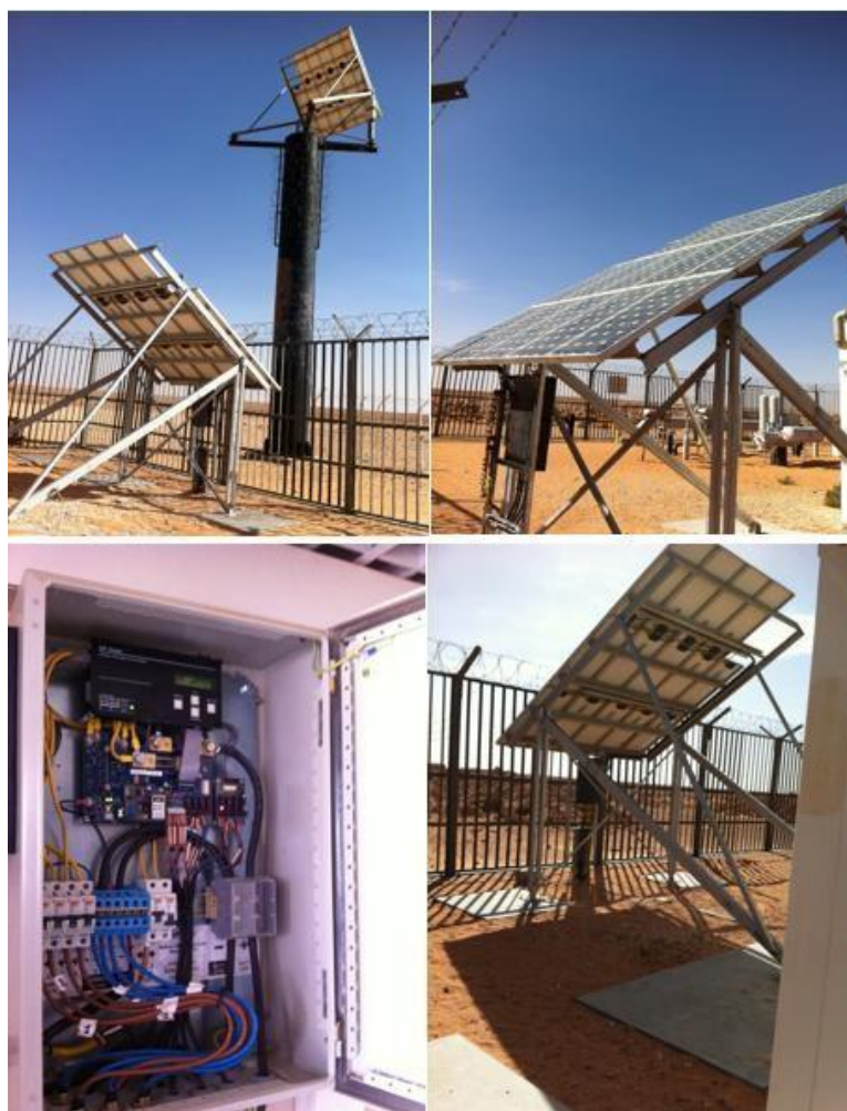
Figure 1-2 : Alimentation par l'énergie photovoltaïque
