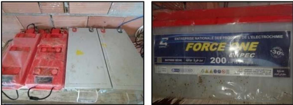
**Figure 72 :** Branchement de 4 batteries de 12V en série
