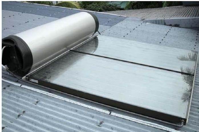
**Figure 25 :** Capteur thermique.
