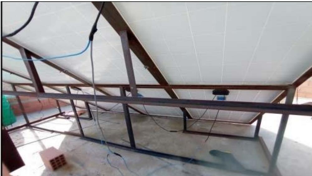
**Figure 69 :** Représentation de la connexion de 8 panneaux.
