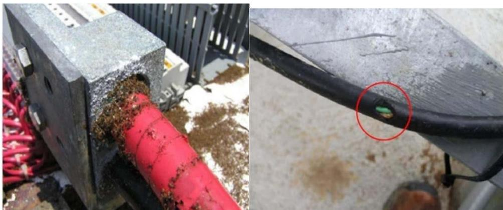
**Figure 33:** Exemple de défauts rencontrés dans le système de câblage
