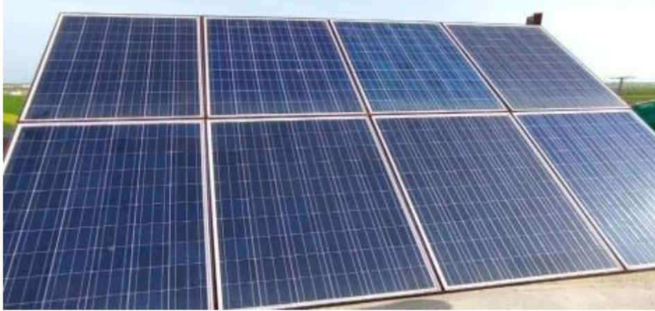
**Figure 68 :** Générateurs PV solaire de 8 panneaux de 48V (connexion mixte).
