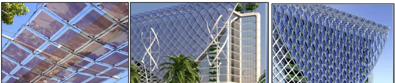
Figure 66 : Les Cellules Solaires Photovoltaïques intégrés au projet
