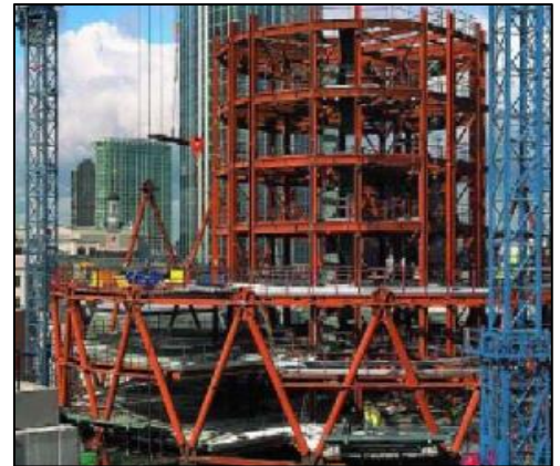
Figure 78 : structure de la façade
