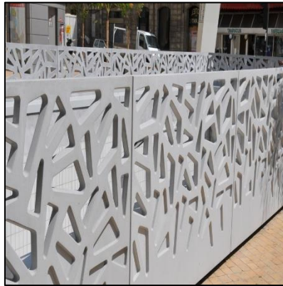
Figure 172 : brises soleil en GRC
