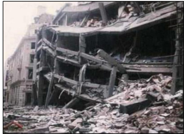
Figure 73 : Le bâtiment après l'explosion source : http://www.skyscrapercity.com
