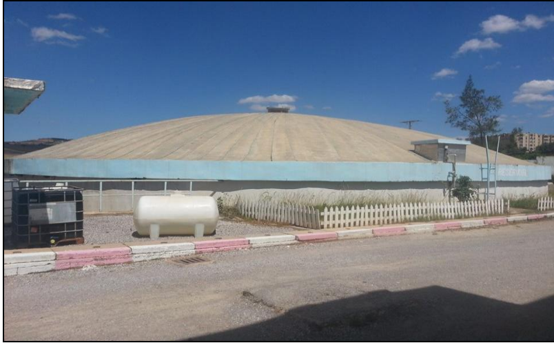
Figure 07 : Réservoir de stockage (Cliché Bouzidi pris le 17/03/2017).
