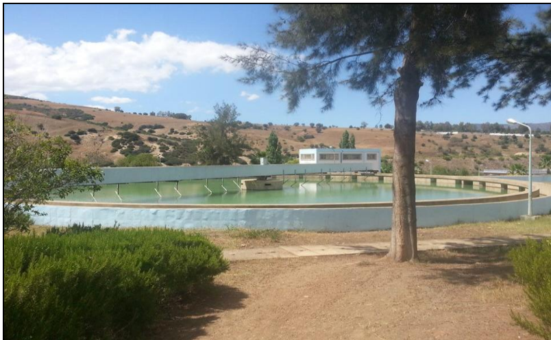
Figure 05 : Bassin de décantation (Cliché Bouzidi pris le 15/03/2017).
