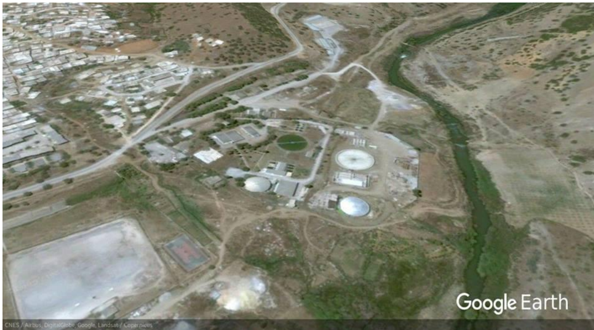
Figure 09 : Photo satellitaire de la station de traitement de Hammam Debagh (Google Earth,).
