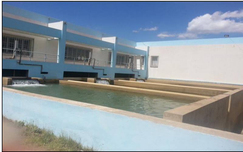
Figure 06 : Bassin de Filtration (Cliché Bouzidi pris le14/03/2017).
