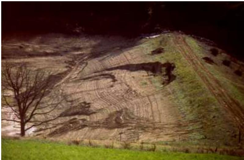
Figure 4.5 : Glissement de parement amont (Source : Irstea)
