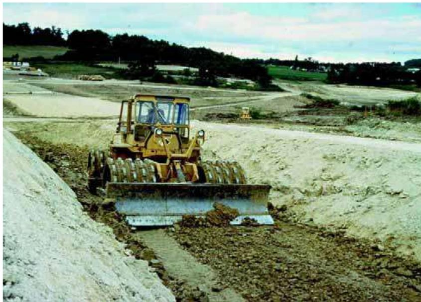
**Figure 2.27** : Compactage d'argile dans la clé d'étanchéité [8]
