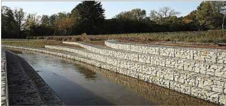
Figure 2.5 : système de protection par gabionnage
