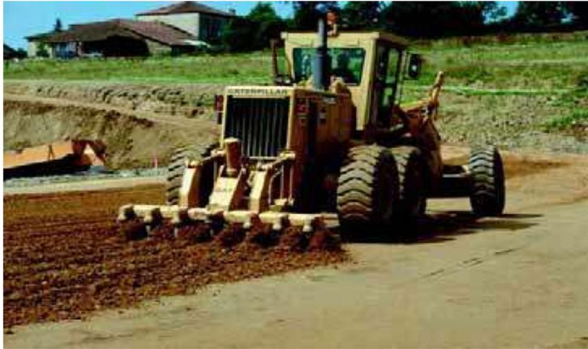
**Figure 2.26** : Scarification après passage d'un rouleau vibrant lisse [8]
