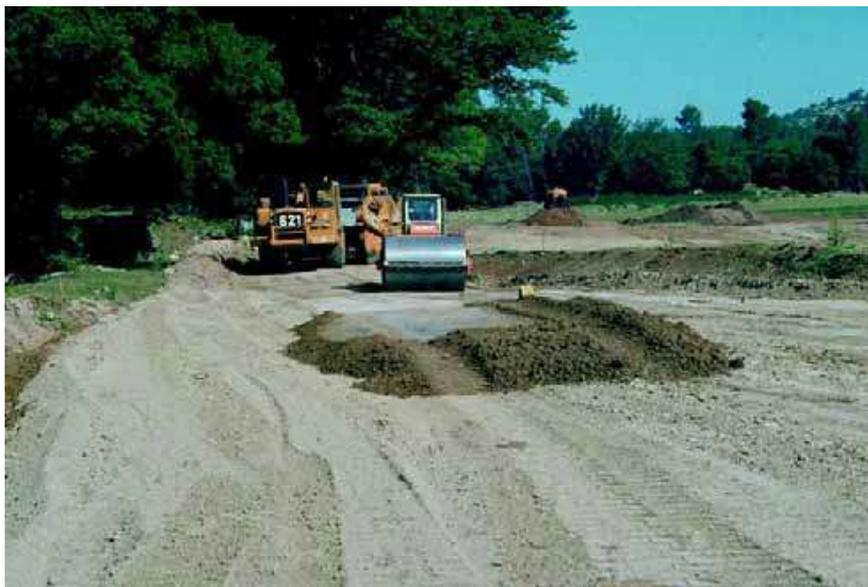
**Fig. 2.28** : Planche d'essai d'un très petit barrage (au fond le compacteur à rouleau lisse et une décapeuse qui amène la terre depuis la zone d'emprunt [8])
