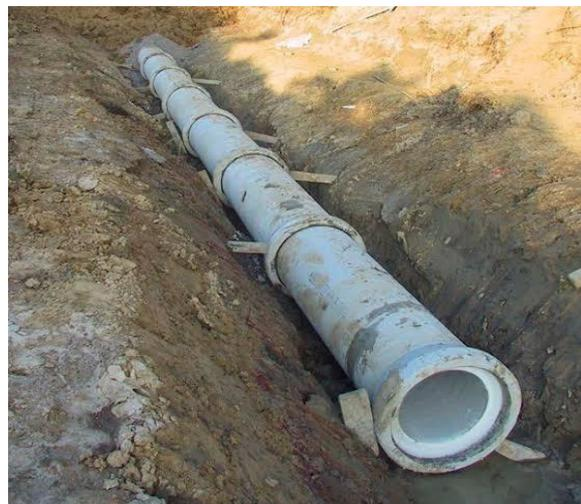
Figure 1.9 : Conduite en béton armé.
