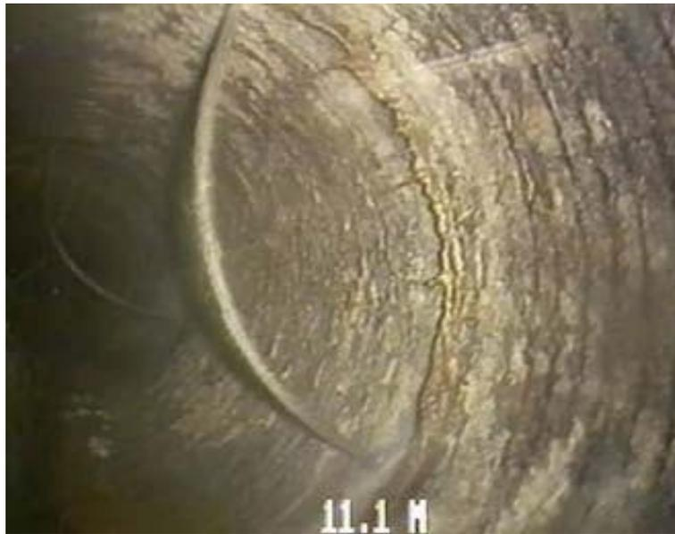
**Figure 2.13 :** Exemple de corrosion par une attaque au H<sub>2</sub>S.
