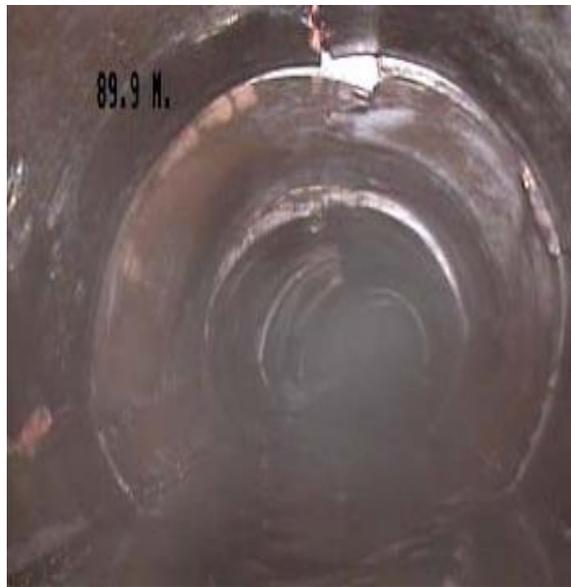
**Figure 2.6 :** déformation de conduite.
