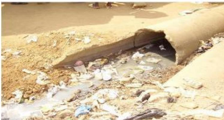
Figure 2.1 : Dégradation d'une conduite d'assainissement.
