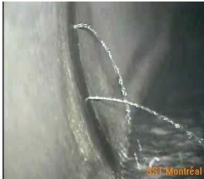
**Figure 2.9 :** Infiltration de conduite.
