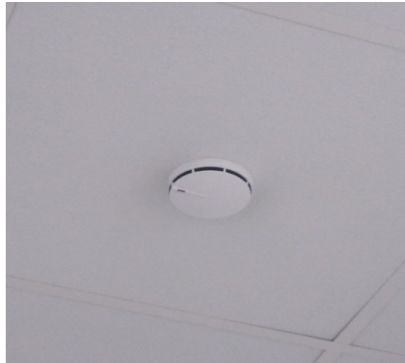
الشكل رقم 07: يبين جهاز كشف الحرائق بمركز الأرشيف ولاية قسنطينة
