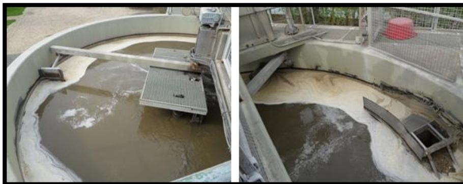
**Figure 3 :** Étape de dégraissage (Marsault *et al.*, 2013).
