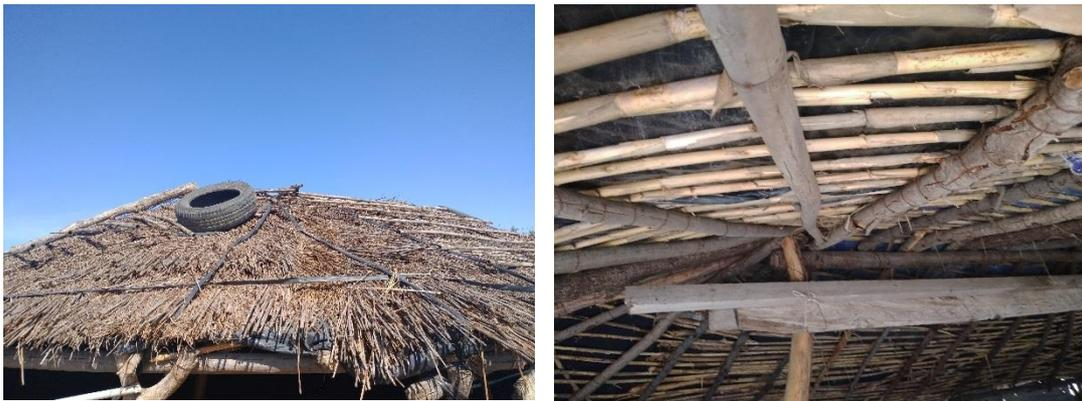
Figure 87: toit d'un gourbis construit avec les roseaux et la Bouse de vache (source auteur,2023)
