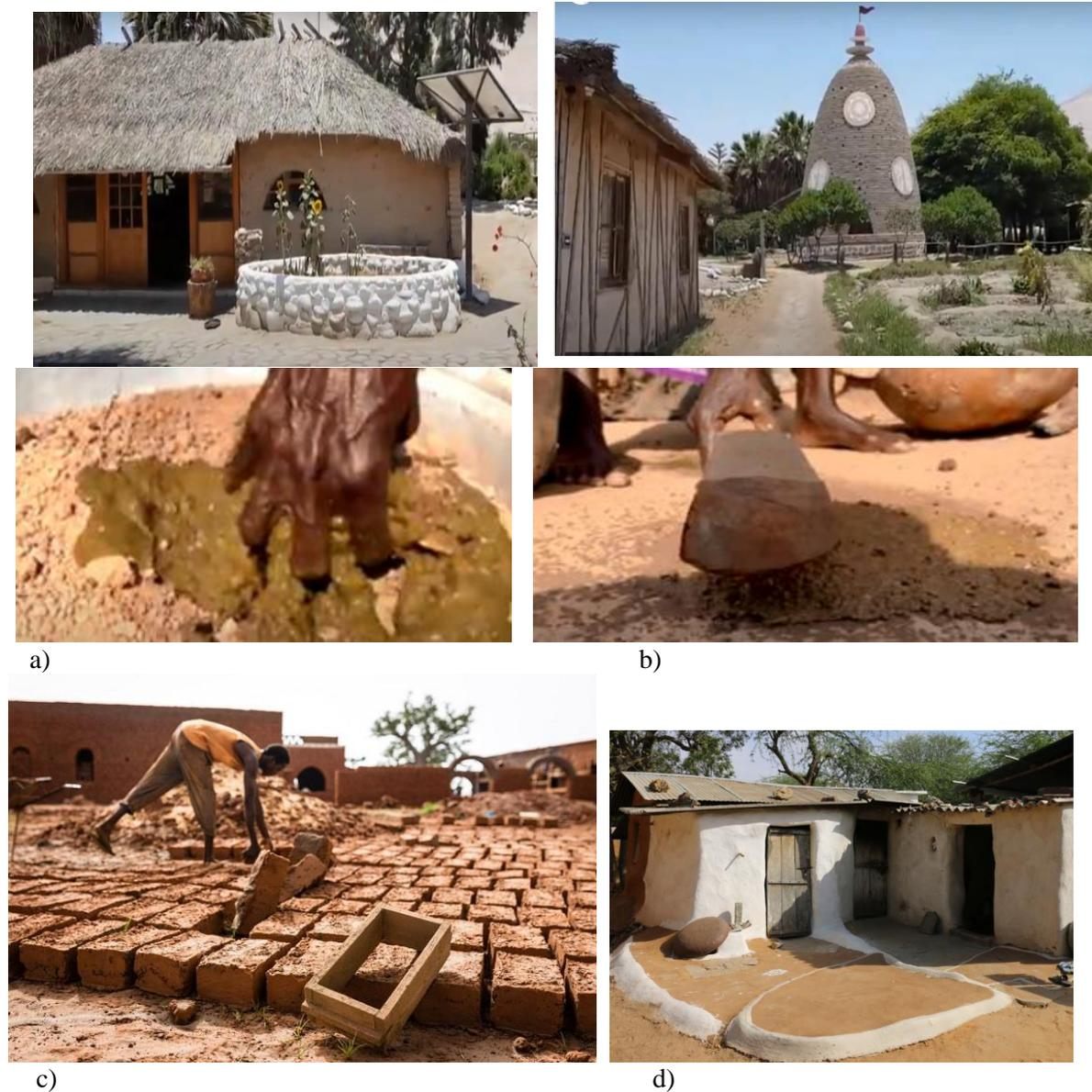
Figure 86: fabrication de béton naturel et les Torchis à partir de terre, de paille et de Bouse de vache.
