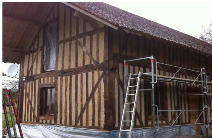
Figure I.4 Construction d'une maison en colombage et torchis.
