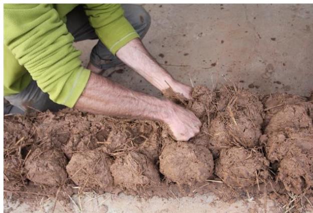
Figure I.5 Système de construction en terre crue empilée (bauge).
