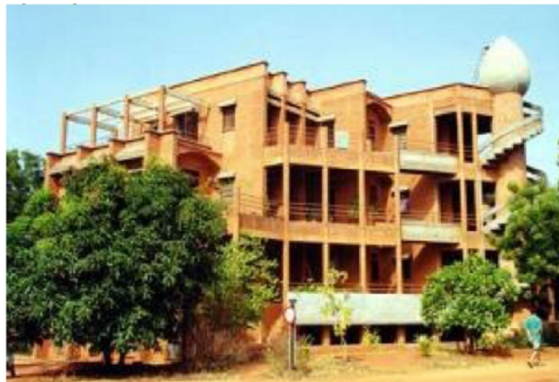
Figure I.10 Bâtiment en brique de terre stabilisée sur 4 étages en Inde[4].
