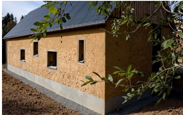
Figure I.6 Construction en terre crue en bauge coffrée
