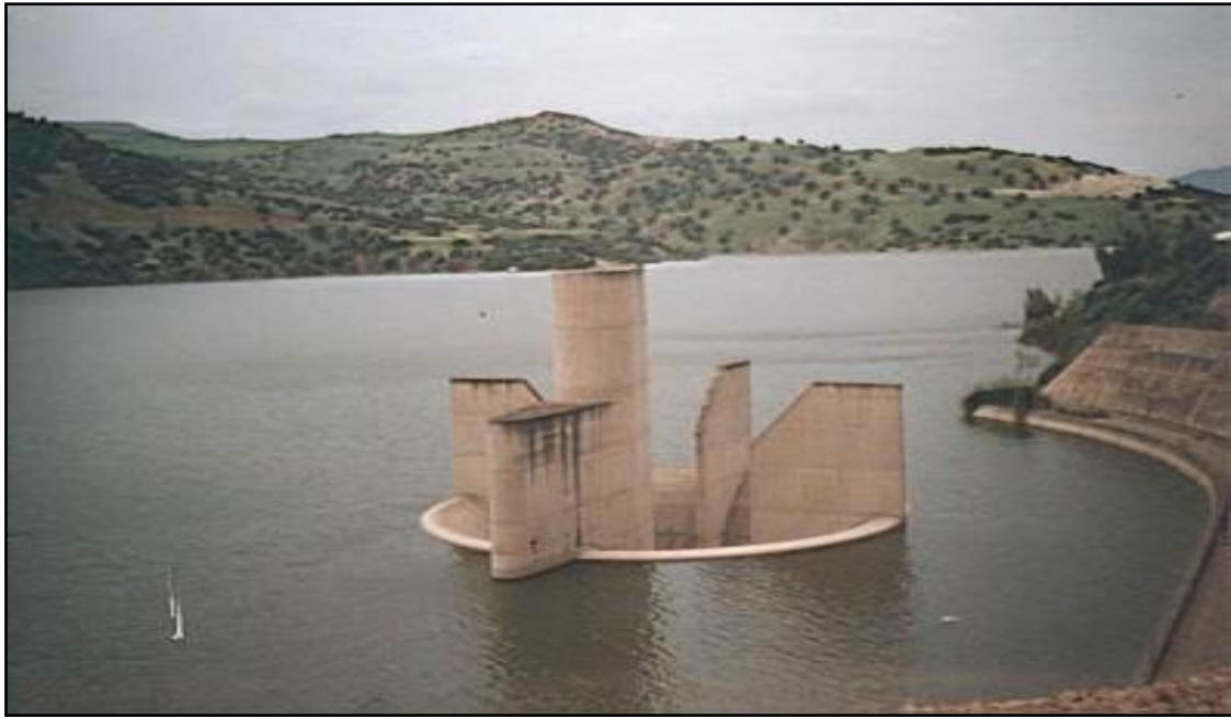
Fig.02: Barrage de Bouhamdane. [1]
