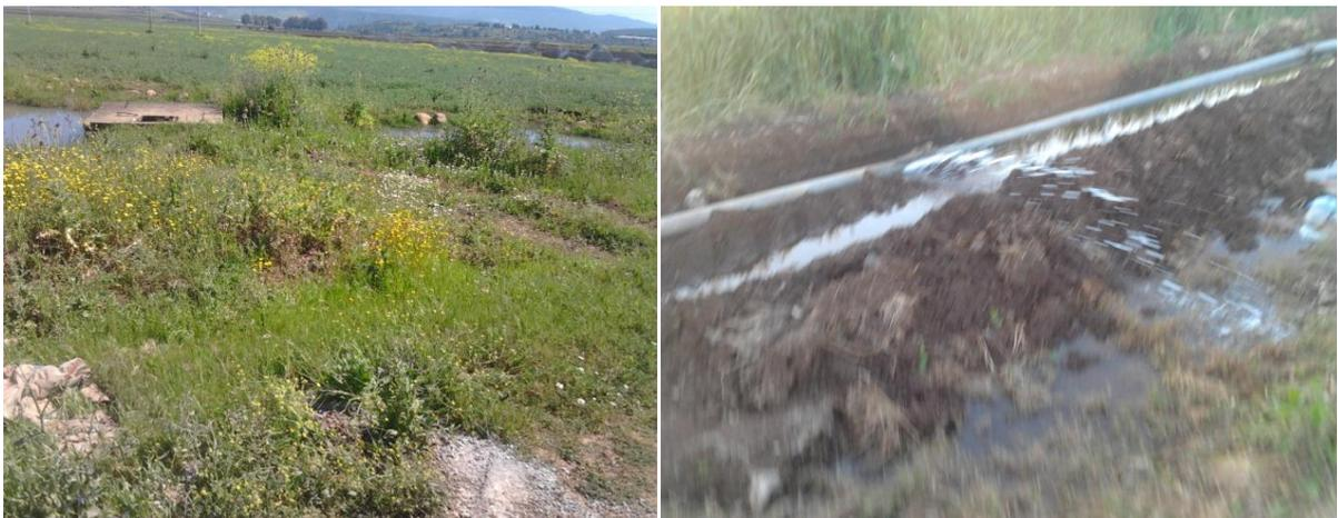
**Figure 16 : Fuite sur le réseau d'irrigation**
