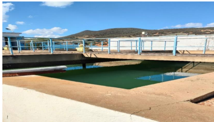
Figure III.3 : Bassin de floculation (agitation lente).
