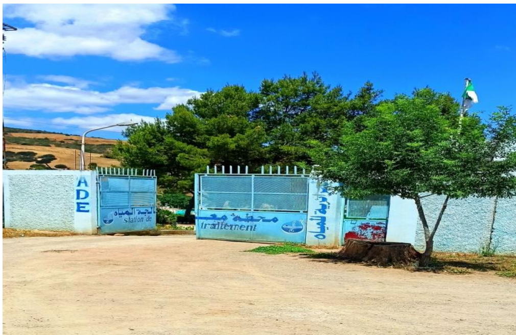
Figure I.5 : Entrée de la Station de traitement des eaux Hamam Debagh
