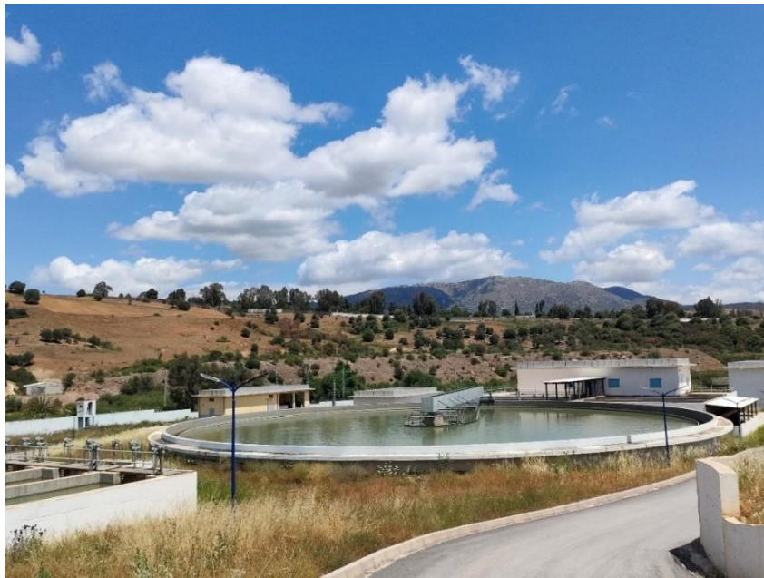
Figure III.4 : Bassin de décantation.
