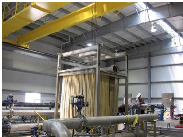
Figure.III.6 : Filtre à membrane.
