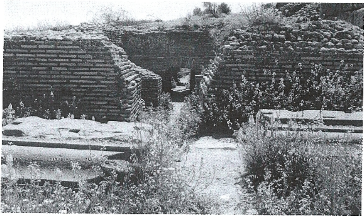
صورة رقم 28 : التفتية القائمة على الأجر Opus Testaceum
