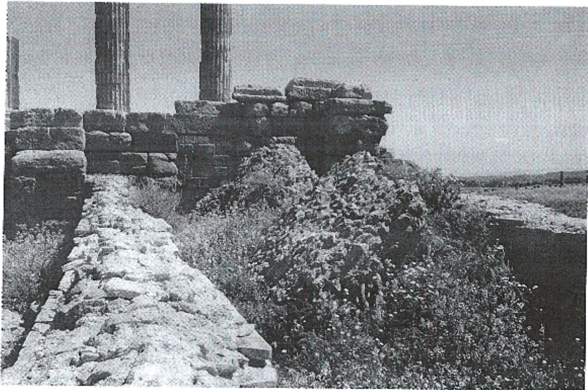
صورة رقم 29 : تفتية مختلطة Opus Mixtum
