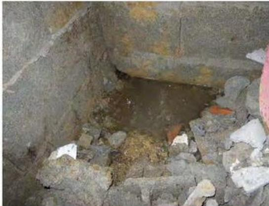
**Figure IV.47** L'eau se diffuse le long de la semelle
