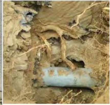
**Figure IV.54** développement des racines sous les géomembranes
