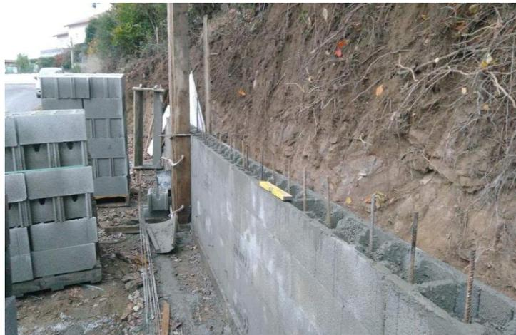
**Figure V.26** Le chaînage vertical d'un mur en parpaings.
