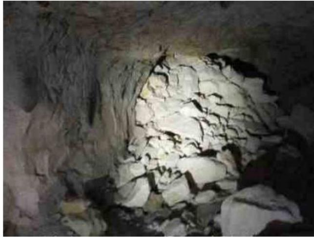
Figure VI.19 Suppression de vide : Foudroyage = provoquer l'effondrement
