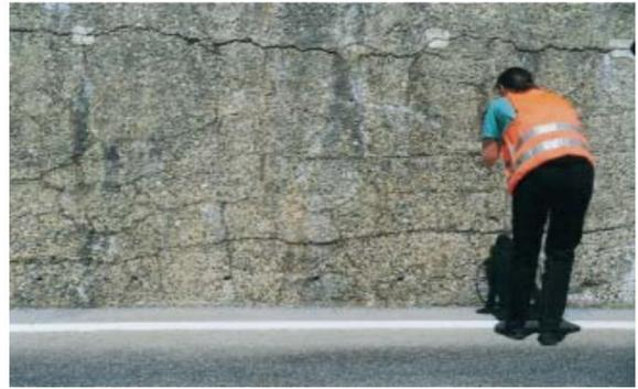
**Figure I.15** Dégâts dus aux RAG dans un mur de soutènement non armé.
