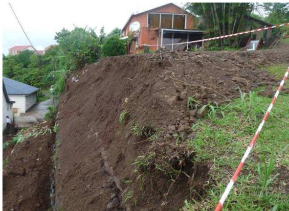
**Figure V.7** Rupture du sol d'assise d'un mur de soutènement.
