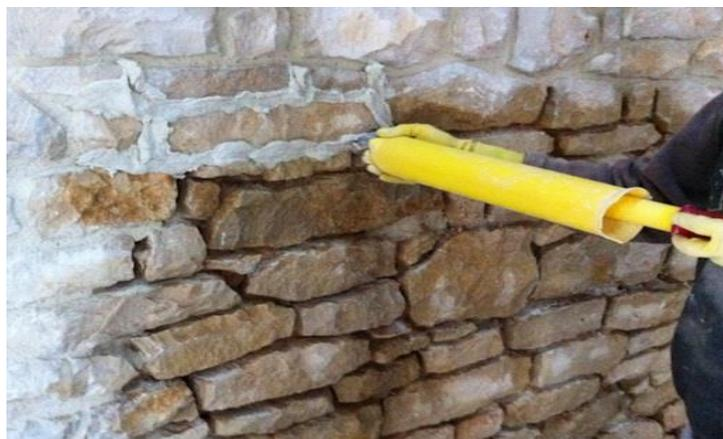
**Figure V.29** Exemple de rejointoiement.
