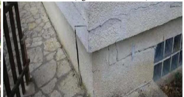
**Figure IV.52** Soulèvement de l'angle amont
