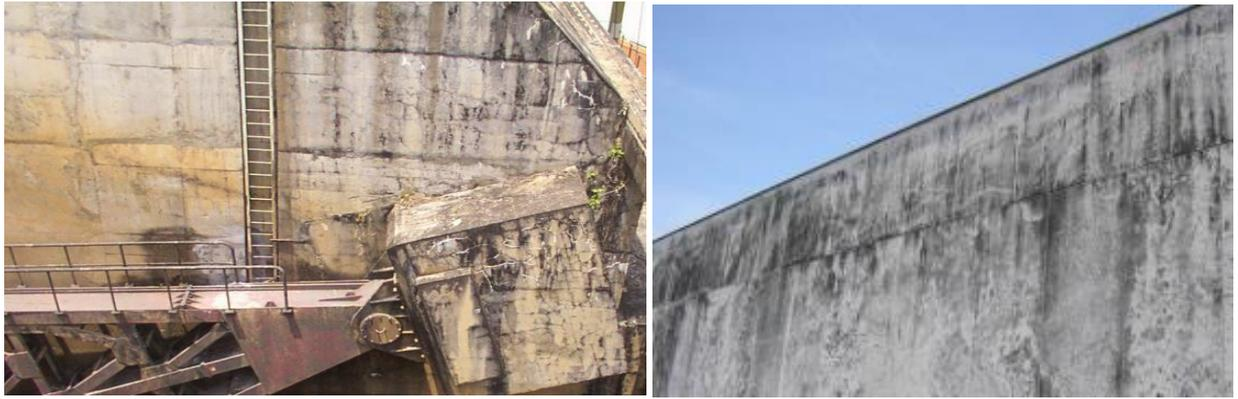
**Figure I.21** Des colorations ou décolorations d'un mur de soutènement.
