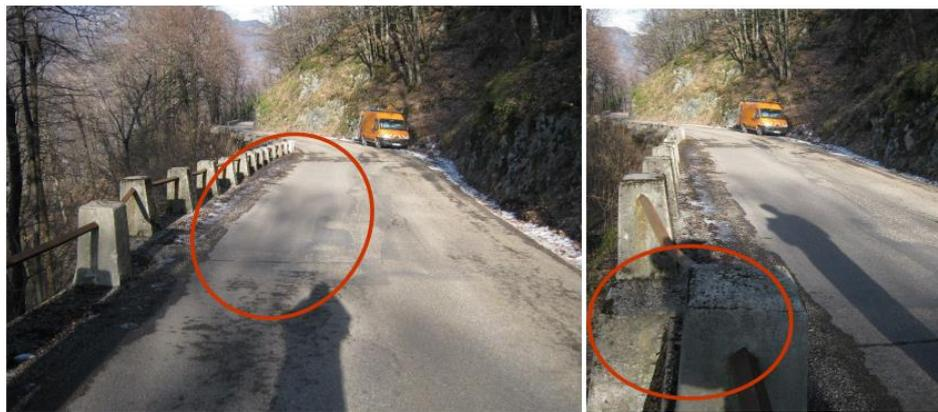
**Figure V.22** Décalage marqué de la tête de mur dus au portion d'enrobés refaite (début d'un tassement différentiel).
