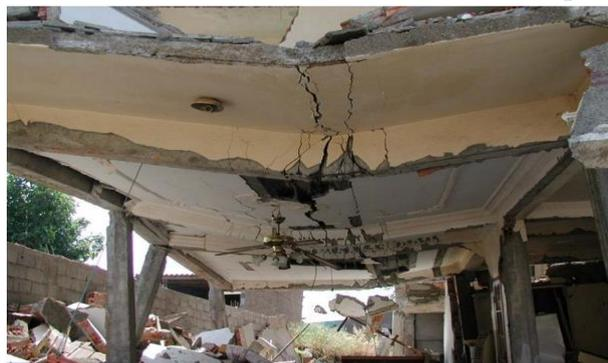
**Figure II.4** Rupture par flexion des poutres.
