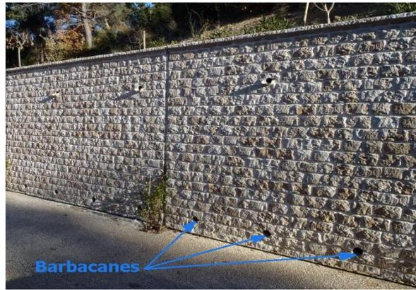
**Figure V.27** S'assurer du bon fonctionnement des systèmes d'évacuation d'eau.
