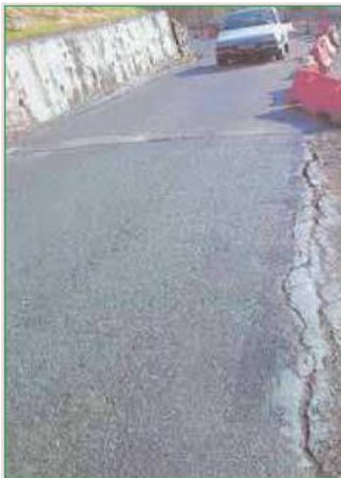
**Figure V.41** Exemple de fissure longitudinale due à une déformation horizontale excessive.
