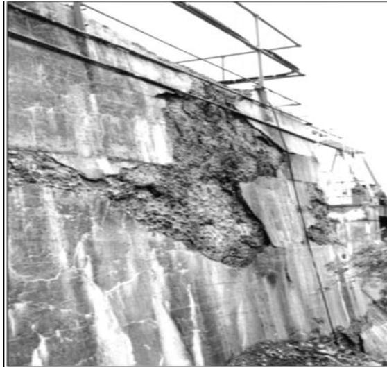
Figure I.25 Exemple de dommages causés par le gel-dégel.
