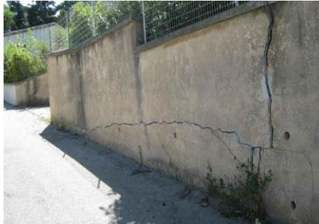
**Figure II.6** Mur de soutènement en choc.
