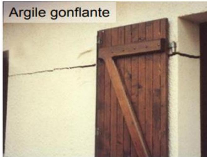
Figure IV.25 Pathologie dus au gonflement des argiles.
