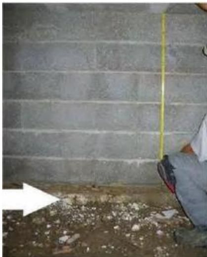
**Figure IV.49** Déchaussement des fondations sous le refond
