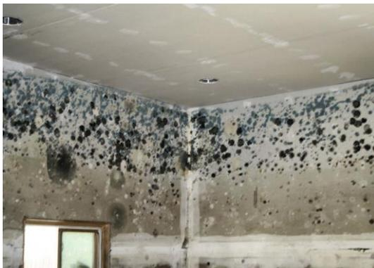
**Figure II.9** Moisissure d'un mur.
