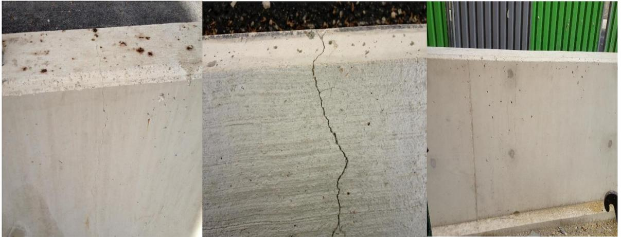
**Figure V.25** Fissurations des murs de soutènements dus au manque des joints de dilatation.
