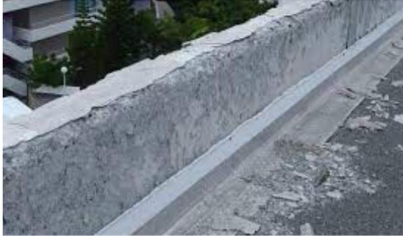
**Figure I.23** La maladie du béton dus à l'ettringite différée.
