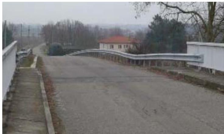
**Figure V.18** Affaissement d'un remblai contigu marqué par la déformation des barrières de sécurité.
