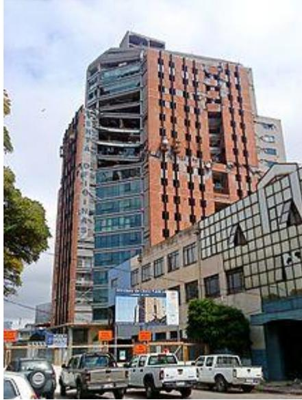
**Figure II.5** La tour O'Higgins de 21 étages s'est partiellement effondrée à Concepción. Le tremblement de terre de 2010 au Chili a provoqué des ruptures de fatigue dans des éléments structurels.
