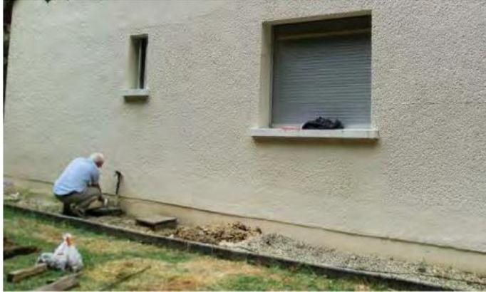
**Figure IV.53** Végétation laissée trop proche de la construction
