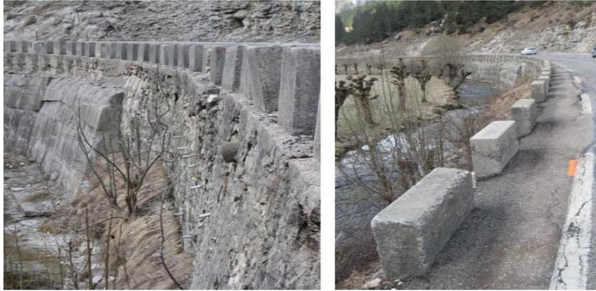
**Figure V.30** Mur en maçonnerie avec mortier à l'état de sable, assainissement et déneigement défavorables Cisaillement du mur sous parapet.
