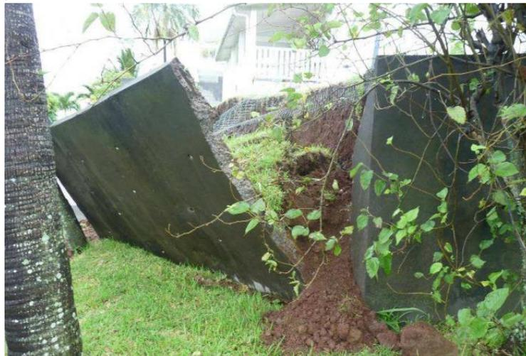
**Figure V.5** Renversement d'un mur de soutènement.
