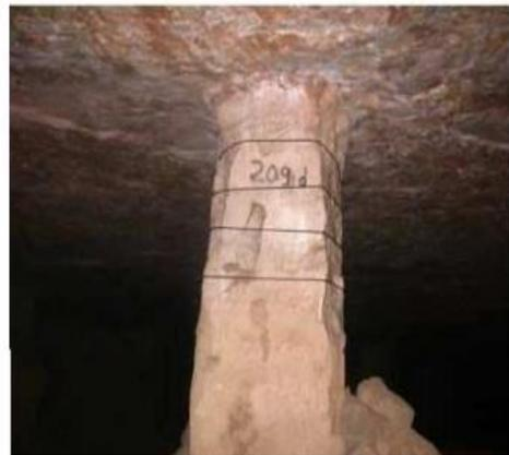
Figure VI.20 Renforcement des piliers réduction de l'occurrence : cerclage
