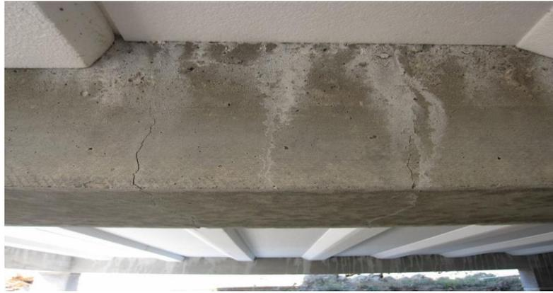
**Figure II.30** Fissures verticales due à l'absence d'armatures de peau.
