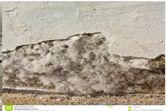
**Figure II.10** Efflorescence grave sur le mur endommagé de sous-sol dans la vieille maison avec la base détériorant de brique.
