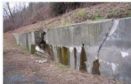
**Figure II.29** La rotation du mur de soutènement due au mauvais emplacement des armatures d'attente.
