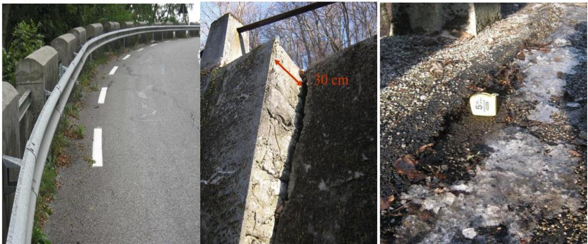
**Figure V.9** Affaissement de chaussée au droit du déversement et glissière fichée.
