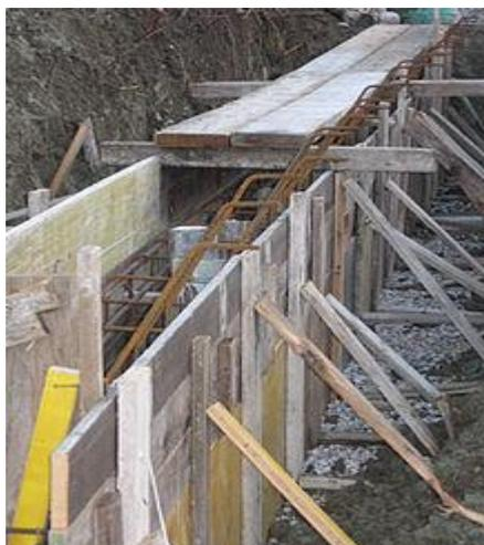
**Figure II.35** étais sur un support déformable.
