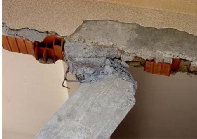
**Figure II.32** Absence d'armatures transversales au niveau du nœud (poteau- poutre).
