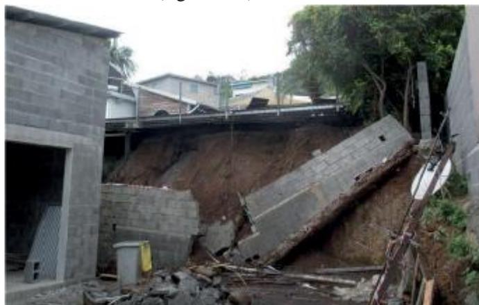
**Figure V.8** Glissement d'ensemble mur/terrain.
