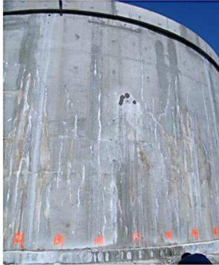
**Figure II.25** Fissures des voiles d'un réservoir.
