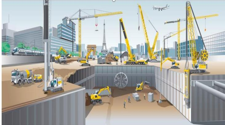
**Figure I.12** Paroi moulée avec radier drainant avec pompage permanent.
