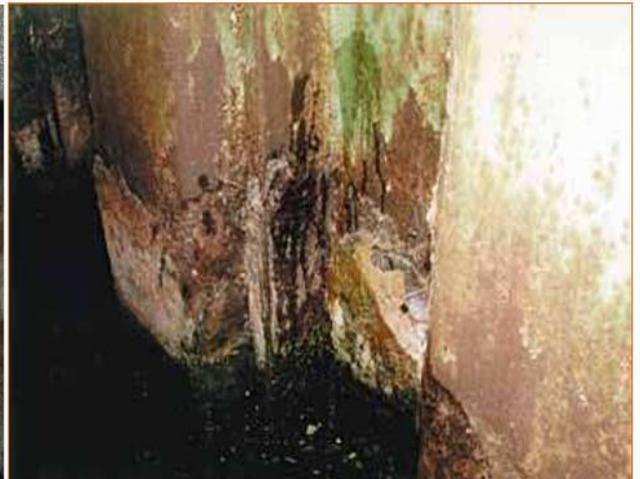
**Figure V.37** Corrosion de palplanches due au concrétions et au dépôts.
