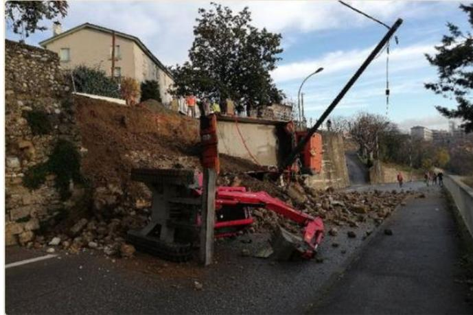
**Figure V.19** Un mur de soutènement s'est effondré en contre-bas.
