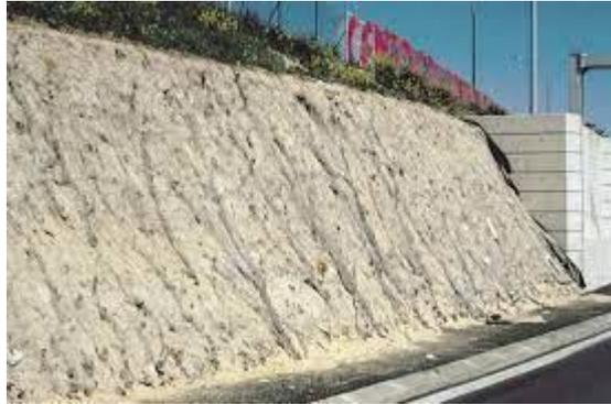
**Figure I.19** Cratères avec des éclatements localisés d'un mur de soutènement.
