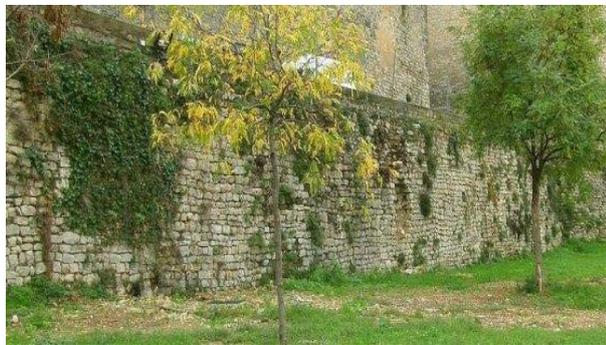
**Figure V.28** Un mur de soutènement nécessitant une dévégétalisation.
