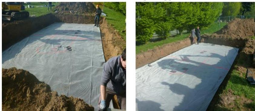
Figure VI.29 Géotextile « parachute »
