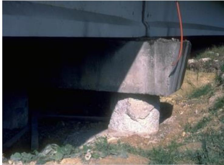
Figure IV.30 Dégradation du béton de pieux.
