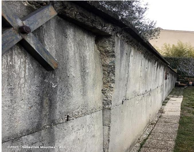
**Figure I.20** Déversement d'un mur de soutènement.
