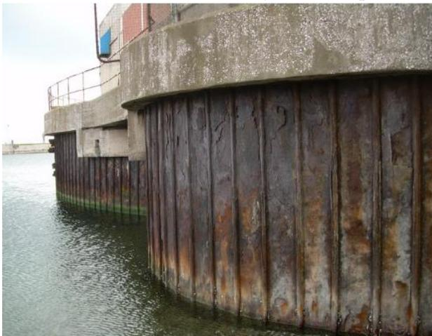
**Figure V.36** Chocs de bateaux au palplanches
