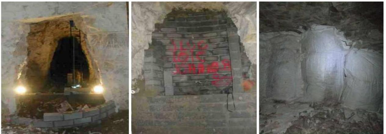
Figure VI.18 Complements autres (mousse,...) peut être aussi partiel avec la mise en place de murs
