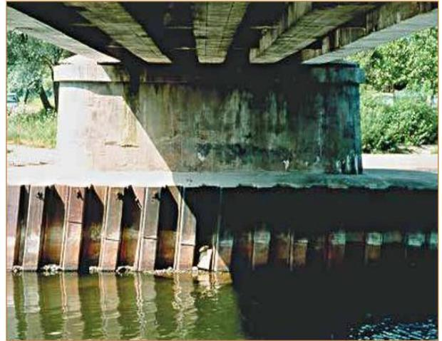
**Figure V.34** Défaut de verticalité des palplanches lié à une mauvaise exécution.
