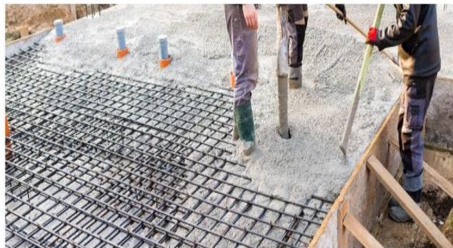
Figure VI.28 Fondations superficielles dimensionnées par rapport au diamètre d'effondrement attendu
