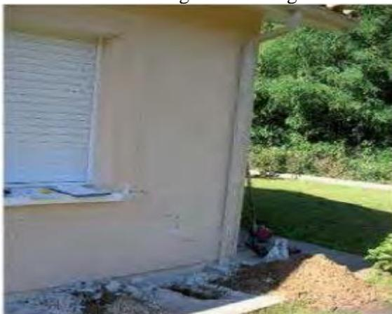
Figure IV.31 Sondage manuel au pied de la fondation sinistrée
