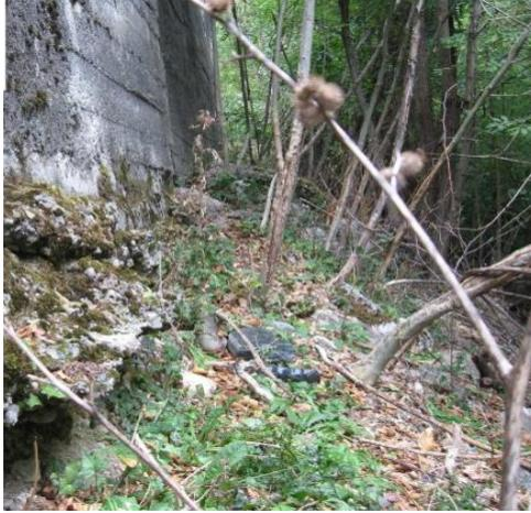
**Figure V.15** Glissement et renversement du mur (absence de fondation et poussée hydrostatique ?).
