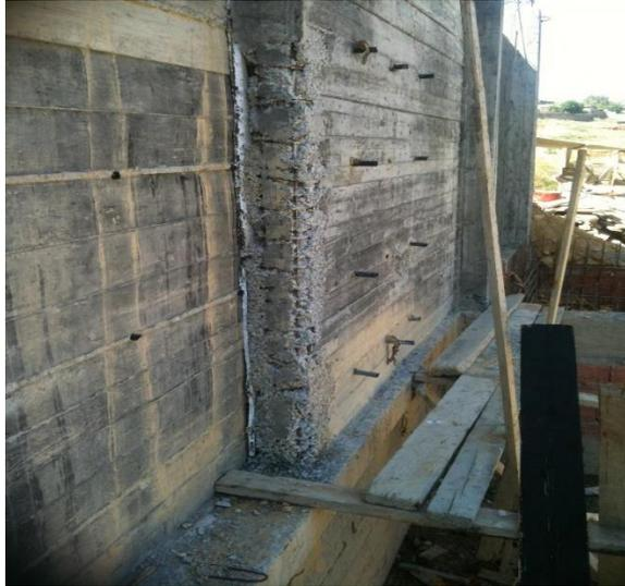
**Figure II.24** Phénomène de ségrégation profonde au niveau des zones critiques d'un mur de soutènement
