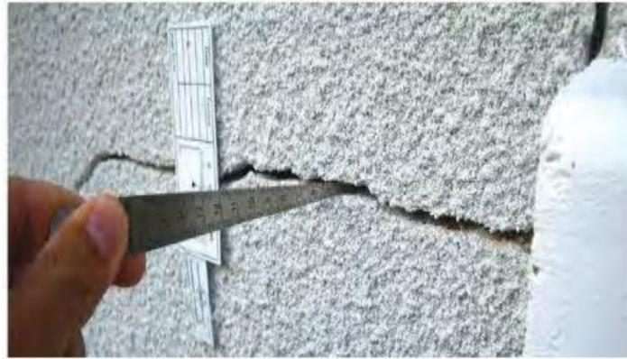
**Figure IV.39** Allure de la fissuration en escalier
