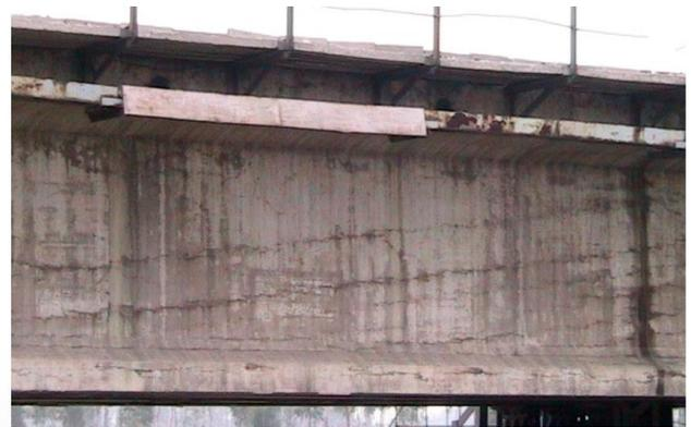
**Figure I.17** Fissuration orientée suivant les efforts de diffusion de la précontrainte.
