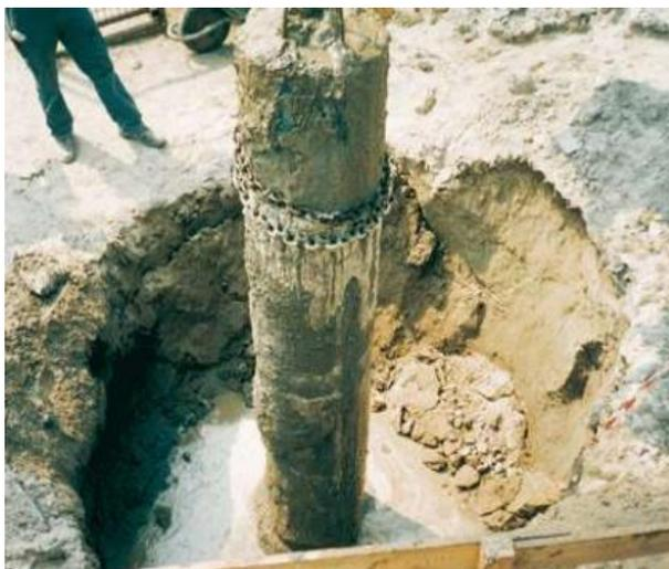
**Figure IV.14** Les défauts de réalisation des fondations profondes.
