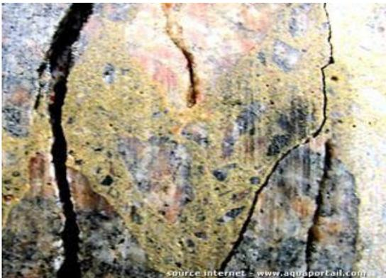
**Figure I.16** Une alcali-réaction sur du béton (faïençage à mailles plus ou moins larges).
