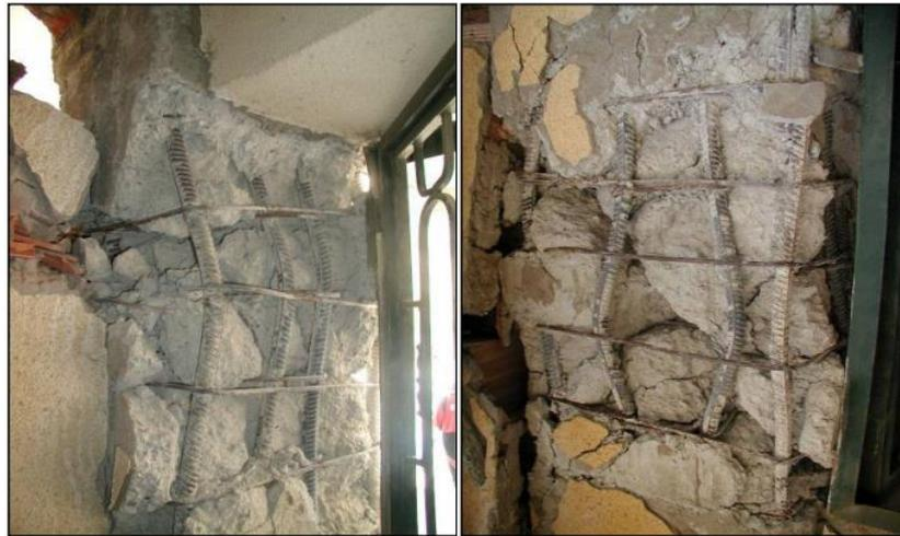
**Figure II.3** Ecrasement de béton et flambement des aciers dans les deux poteaux de la cage d'escaliers.
