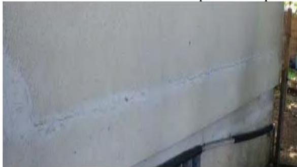
**Figure IV.51** Affaissement de l'angle aval avec la fermeture de la fissure principale
