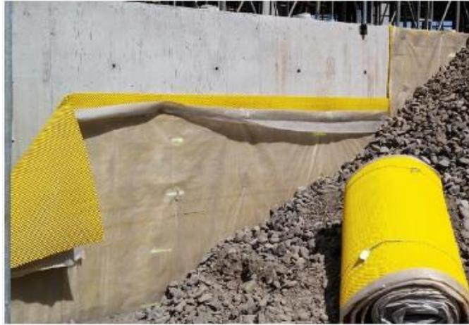
**Figure V.23** Drainage correct avec géotextile.
