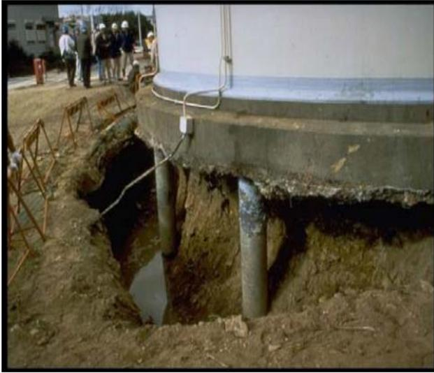
**Figure III.21** Bon sol a permis d'éviter à la citerne de basculer Séisme de Kobé, 1995.
