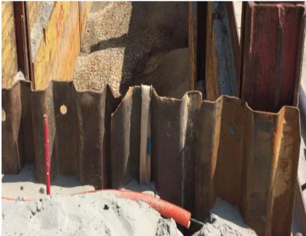
**Figure V.33** Défaut de dégrafâges des palplanches.
