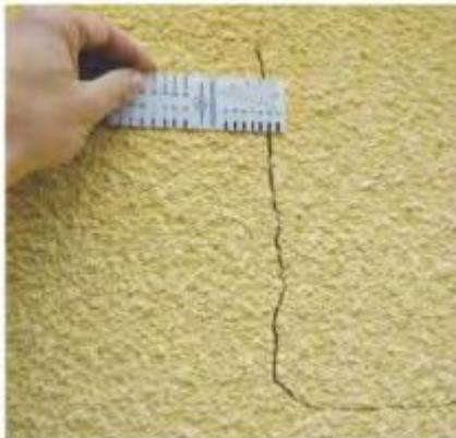
Figure IV.37 Fissures des maçonneries en escalier en angle de la façade arrière
