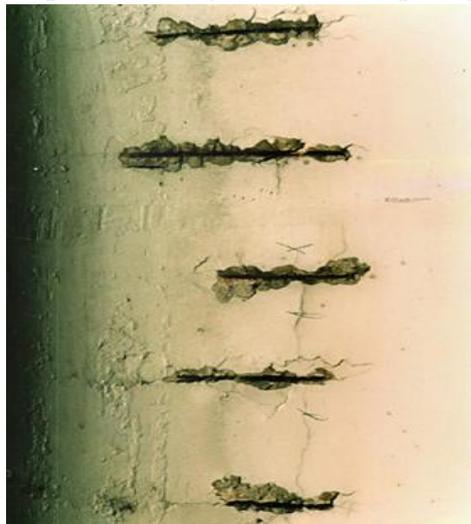
**Figure II.33** Armatures apparentes corrodées: problème d'enrobage insuffisant.
