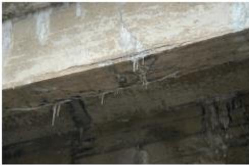
Figure II.19 Gonflement et fissures le long des aciers due à la corrosion.
