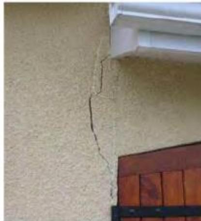
**Figure IV.40** Défaut de jonction déjà réparée
