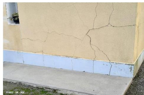
Figure II.20 Fissure due au retrait gonflement d'argiles.
