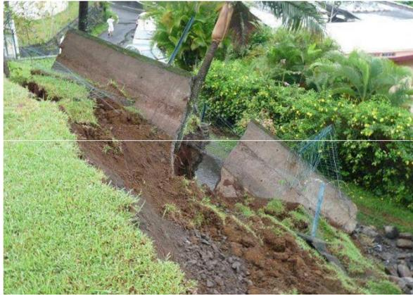
**Figure V.6** Glissement sur la base d'un mur de soutènement.
