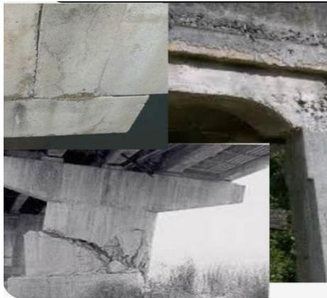
**Figure II.31** Cisaillement due au longueur de recouvrement insuffisante.
