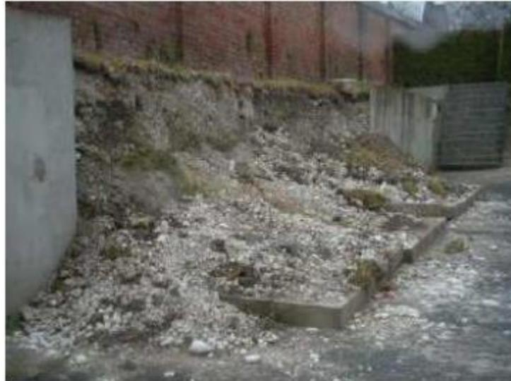
**Figure V.10** Renversement complet du mur.
