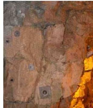
Figure VI.21 Renforcement des piliers réduction de l'occurrence
