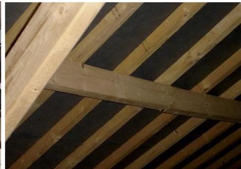
Figure II.22 Déformation du au fluage flexionnel de pannes de toiture.
