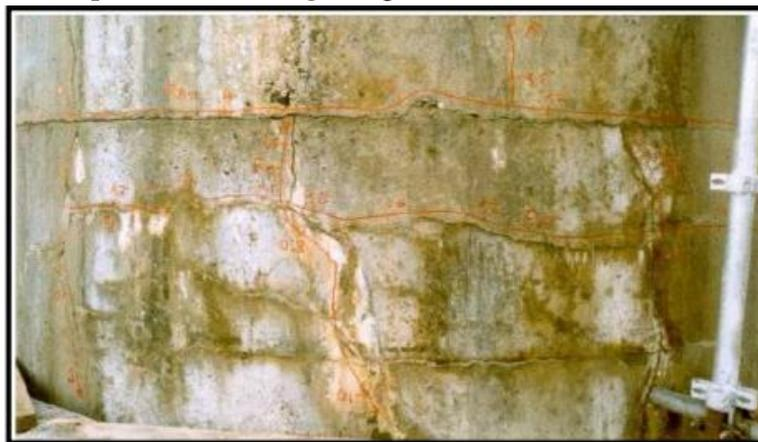
**Figure I.22** Fissuration / faïençage du parement.
