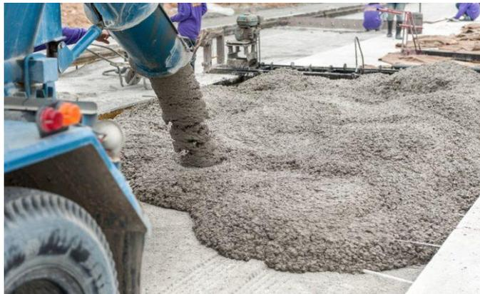
**Figure II.23** Exemple d'un béton non conforme.
