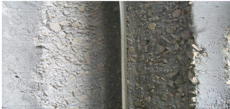
**Figure II.27** Résultat d'une mauvaise reprise de bétonnage.
