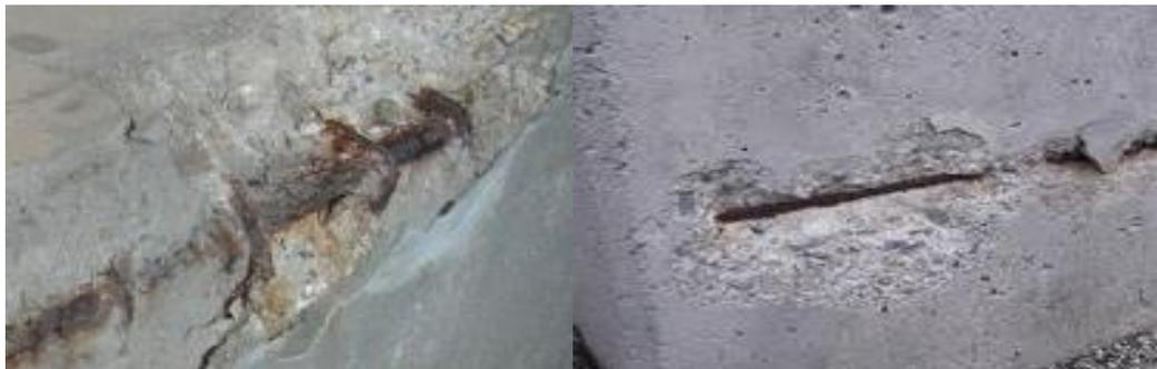
**Figure I.28** Une pathologie accidentelle majeure du béton : la carbonatation.
