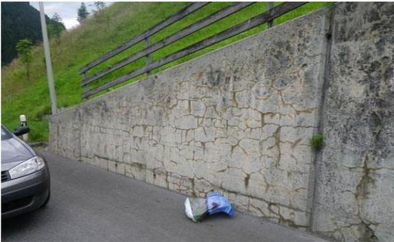
**Figure I.14** Fissures dues à la RAG dans un mur en aile.
