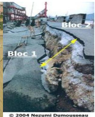
**Figure III.18** L'émergence de la faille en surface avec modification du paysage.
