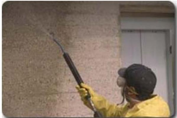
**Figure VI.5** Technique de restauration d'une surface atteinte par la carbonatation
