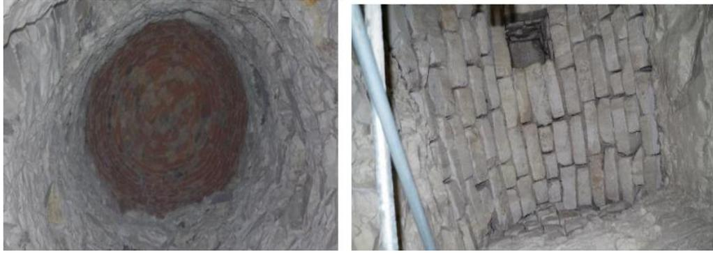
**Figure III.7** Exemple des fermetures de tête de puits circulaire en briques (Pas-de-Calais) et rectangulaire par maçonnerie en moellons (Marne).
