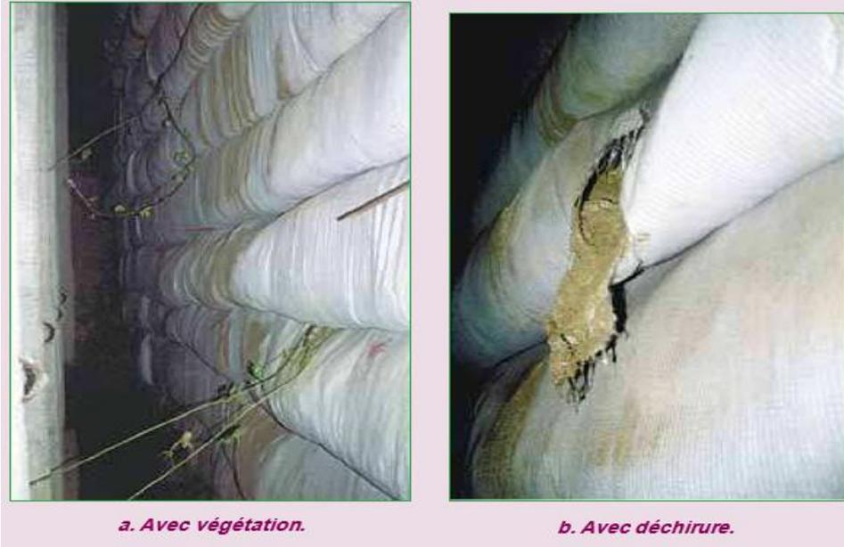
**Figure V.39** Exemples de l'amorce de dégradation des nappes par développement de végétation et par déchirure (parement de protection en béton avec espace visitable).
