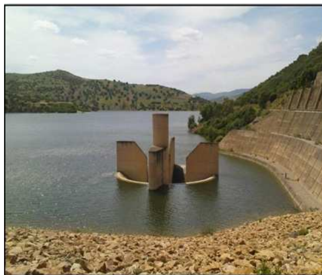
Figure 2.3: Le barrage de Hammam Debagh: évacuateur de crues en puits de section circulaire et protection sur la rive gauche
