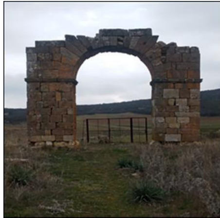
الصورة رقم 15: بوابة تيفاش.
