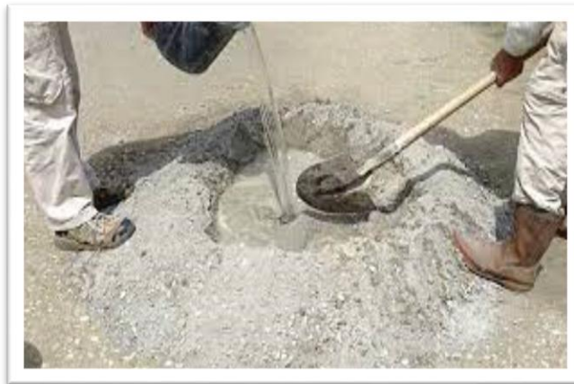
Figure I.4 : Exemple d'une fabrication des mortiers à la main. [9]
