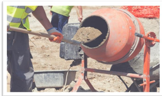
Figure I.5 : Exemple d'une fabrication des mortiers mécanique. [9]
