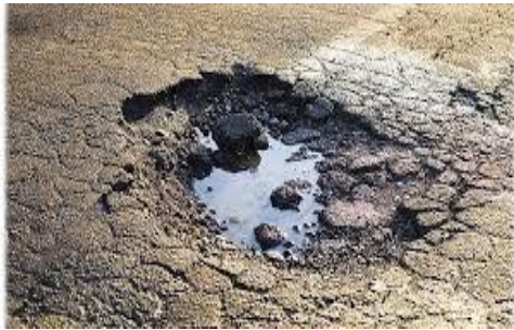
Figure III 13 : Nid de poule
