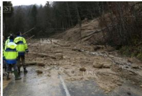
Figure III 16 : affouillement du pied de talus.
