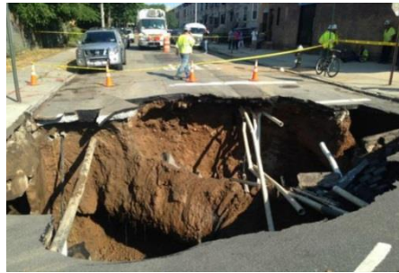
Figure III 14 : Affaissement.
