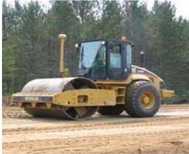
Fig 2-1 Stabilisation mécanique - Compactage
