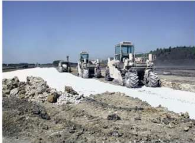
Fig. 3-5 traitement du sol par la jette de la chaux
