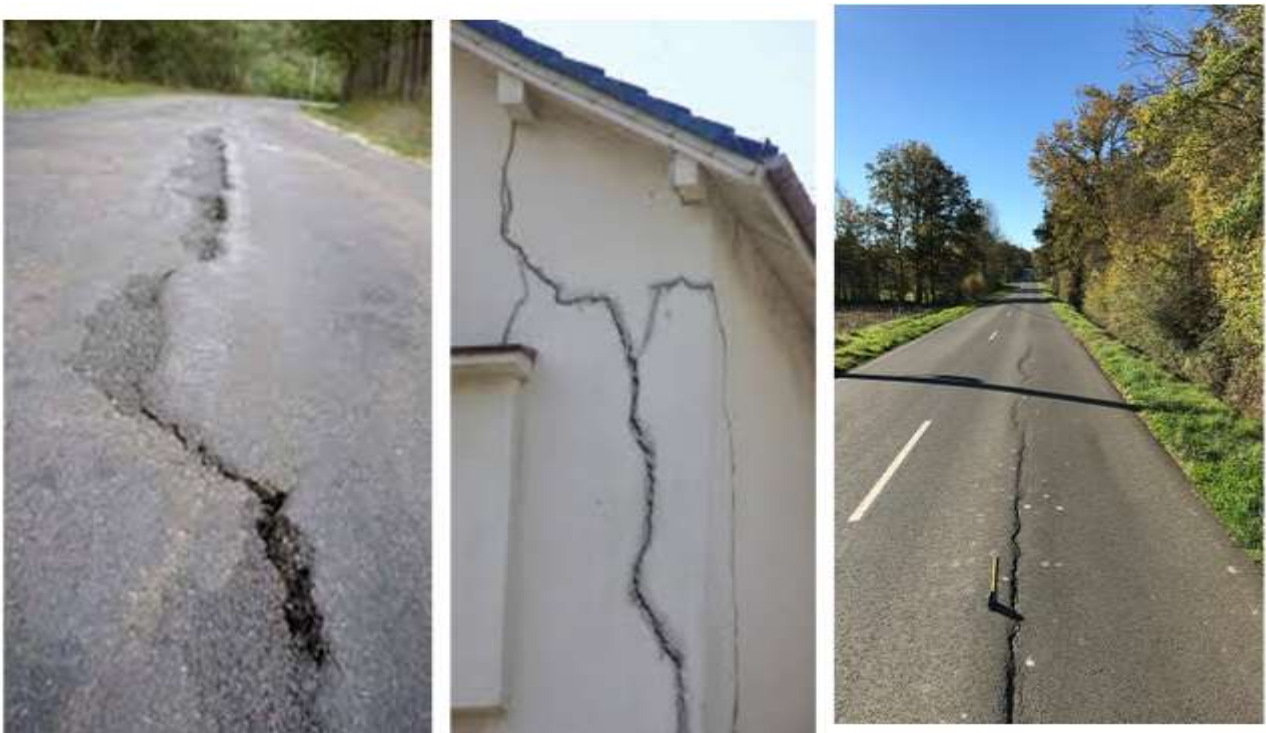
Fig 1-10 Phénomènes de Gonflement des Argiles.
