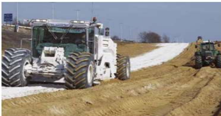
Fig 2-3 Traitement par malaxage
