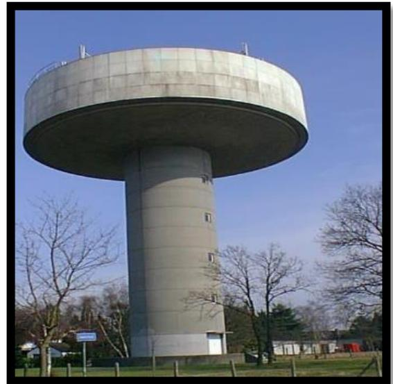
Figure 1.19 : Cuve à fort encorbellement
