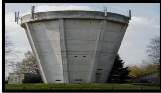
Figure 1.18 : Cuve conique avec fût droit ou fût conique
