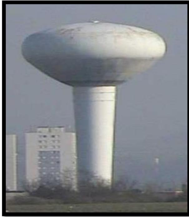
Figure 1.22 : Cuve à fond sphéroïdal
