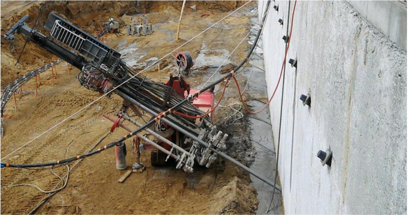
**Figure II.7 :** Les tirants d'ancrage en cours d'exécution [19].
