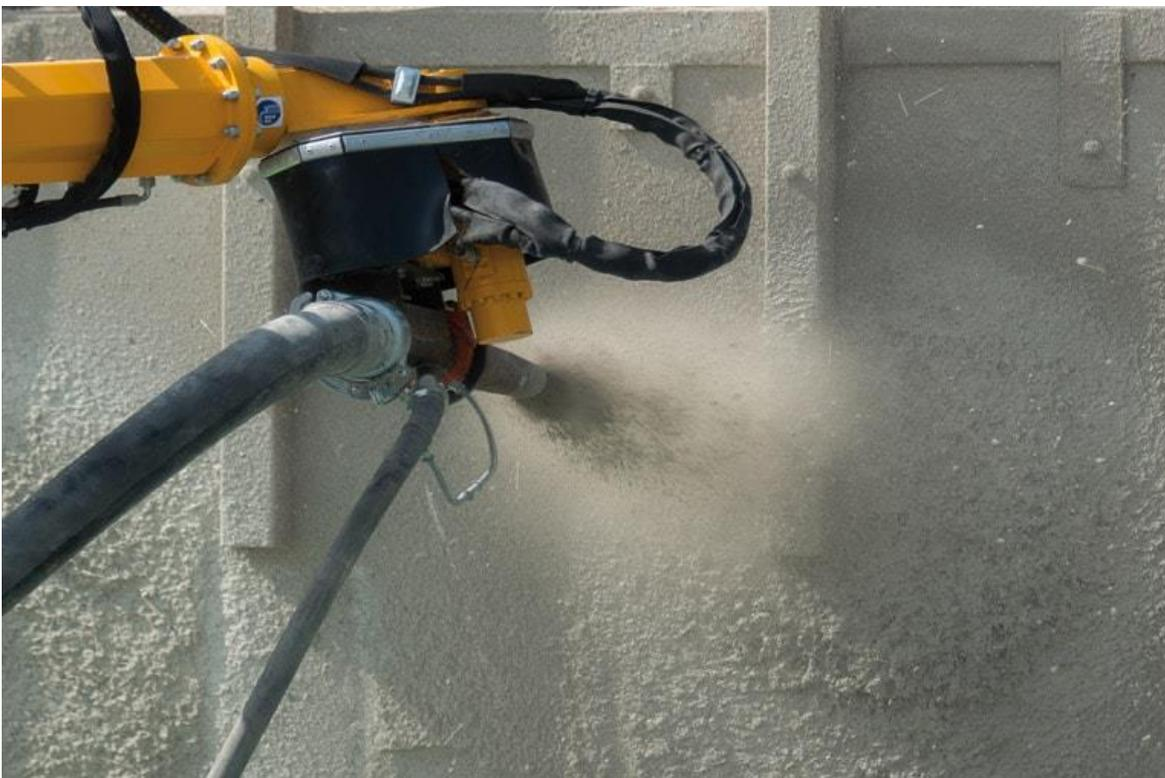
Figure II.5 : projection de béton projeté.
