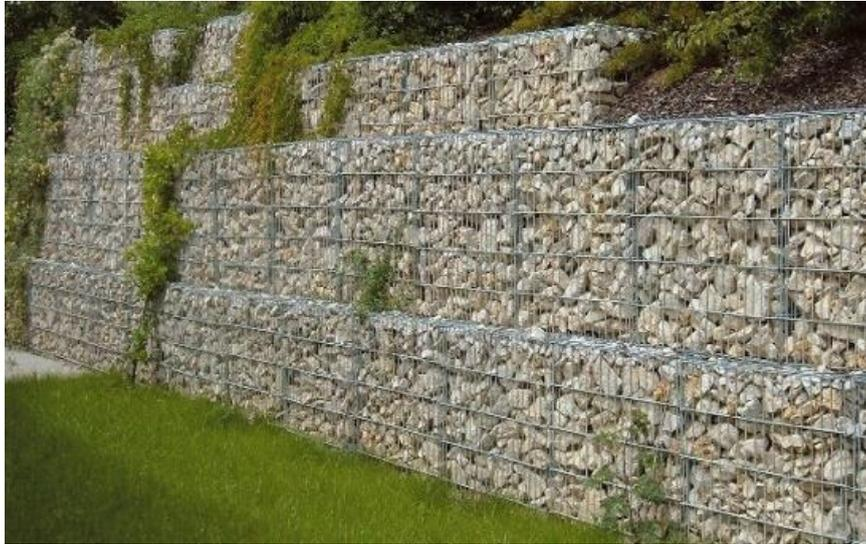
**Figure I.4 : Mur en gabions.**
