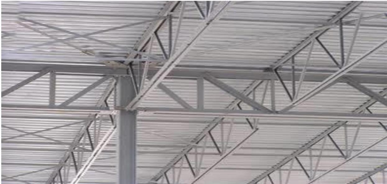
**Figure 6 :** Structures en treillis
