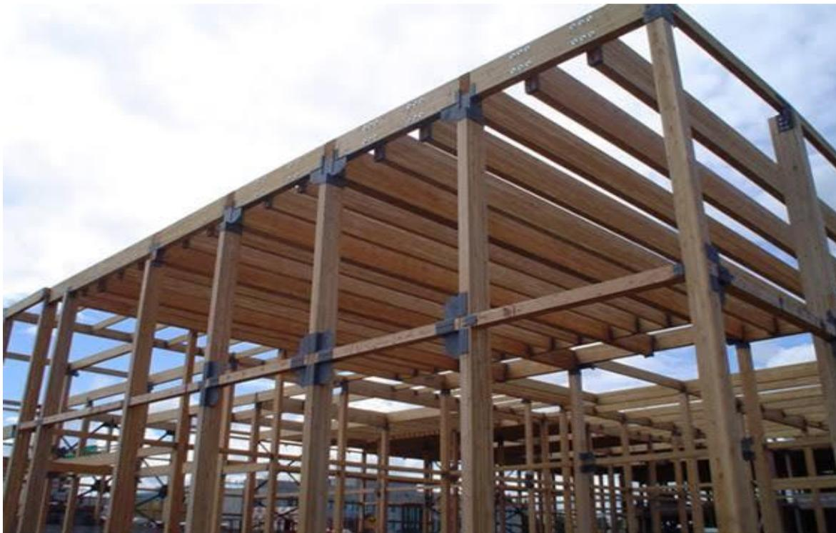
**Figure 2 :** Structures à poutres et colonnes en bois
