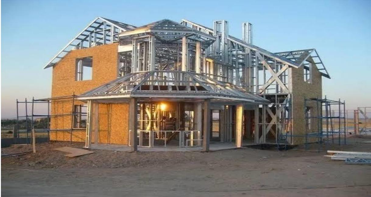
**Figure 15 :** Structures en acier léger
