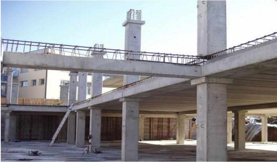
**Figure 1 :** Structures à poutres et colonnes en béton armé
