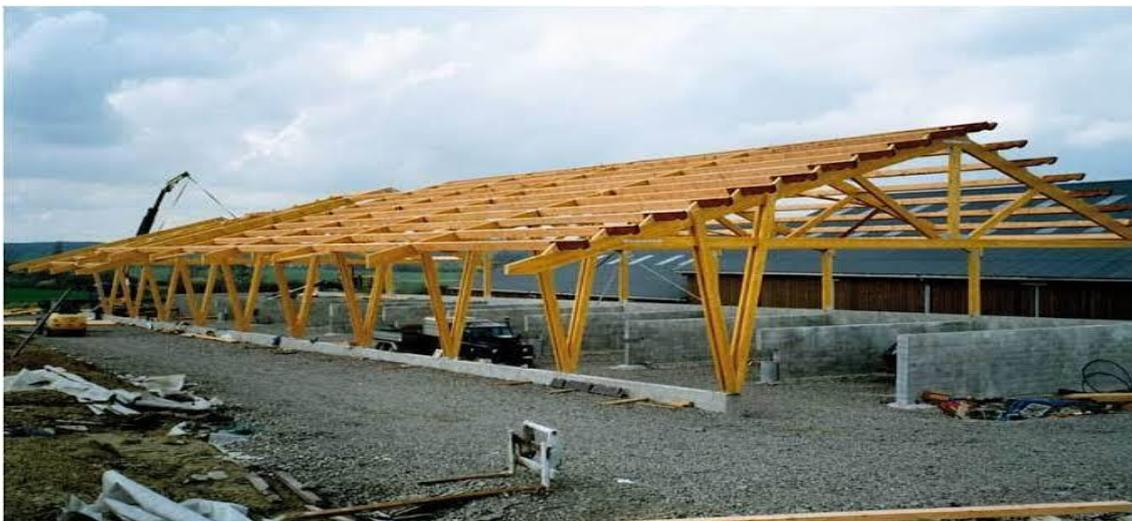
**Figure 16 :** Structures en bois lamellé-collé
