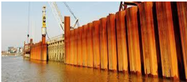
Figure I.6 Paroi en palplanche
