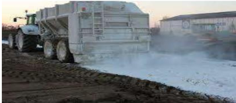
Figure I.18 Stabilisation à la chaux
