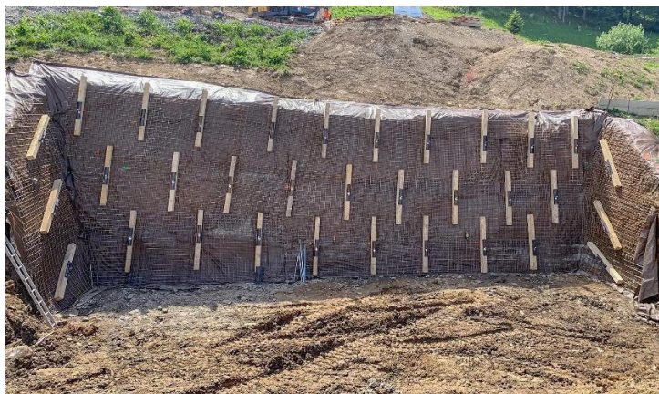
Figure I.5 Paroi ancrée
