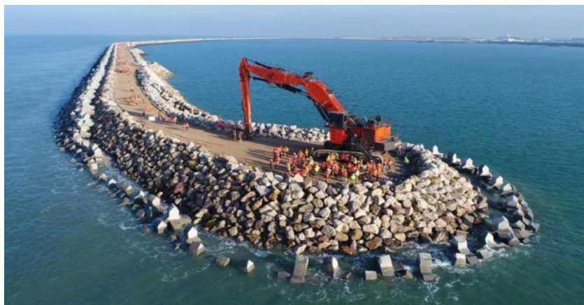
Figure II.4 Construction d'un remblai digue
