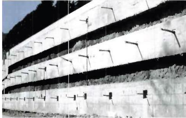
Figure I.9 Les voiles et poutres ancrés
