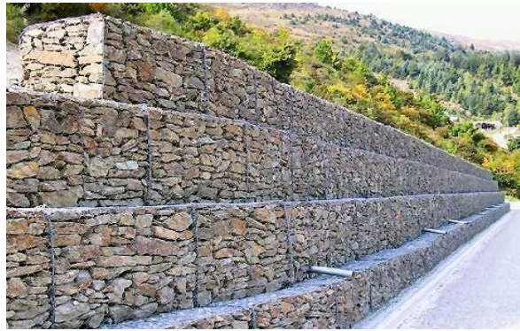
Figure I.1 Mur poids en pierre sèche
