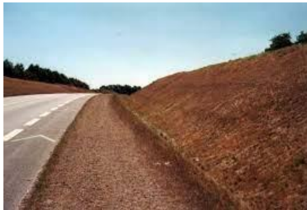
Figure II.5 Remblai qui permet de réduire la nuisance sonore provoquée par le passage des véhicules
