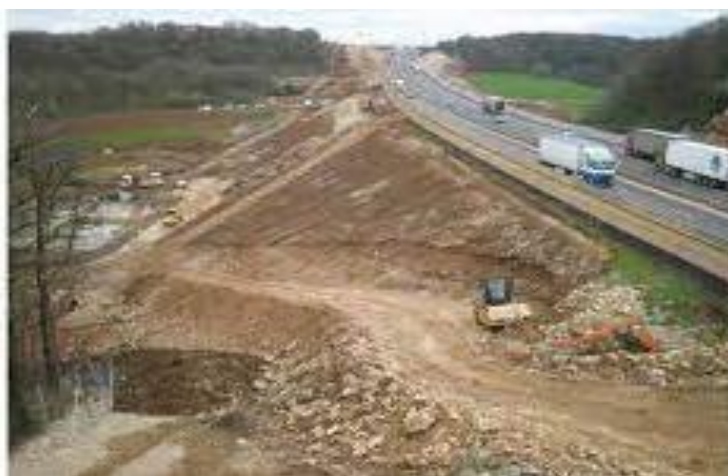
Figure II. 1 Remblai de grande hauteur
