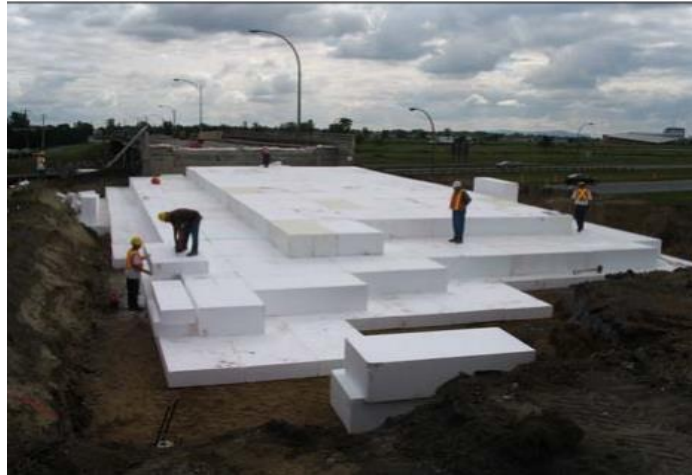
Figure II.10 Remblai léger en polystyrène
