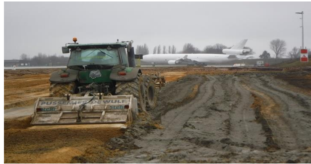
Figure I.19 Traitement par ciment
