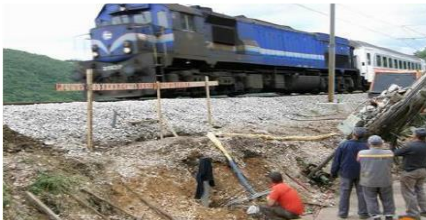
Figure II.6 Amélioration d'un remblai de chemin de fer
