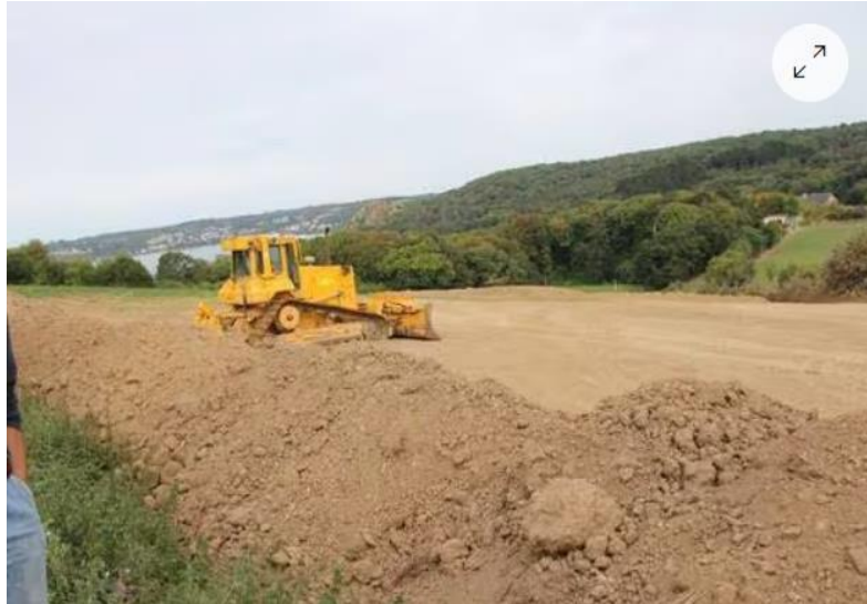
Figure II.7 Stockage d'un matériau excédentaire à un dépôt
