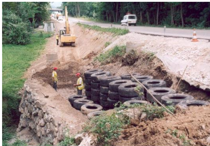
Figure II.13 Soutènement de route renflai allégé - 800pneus – Chambrey
