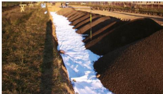
Figure II.9 Remblai en matériaux légers
