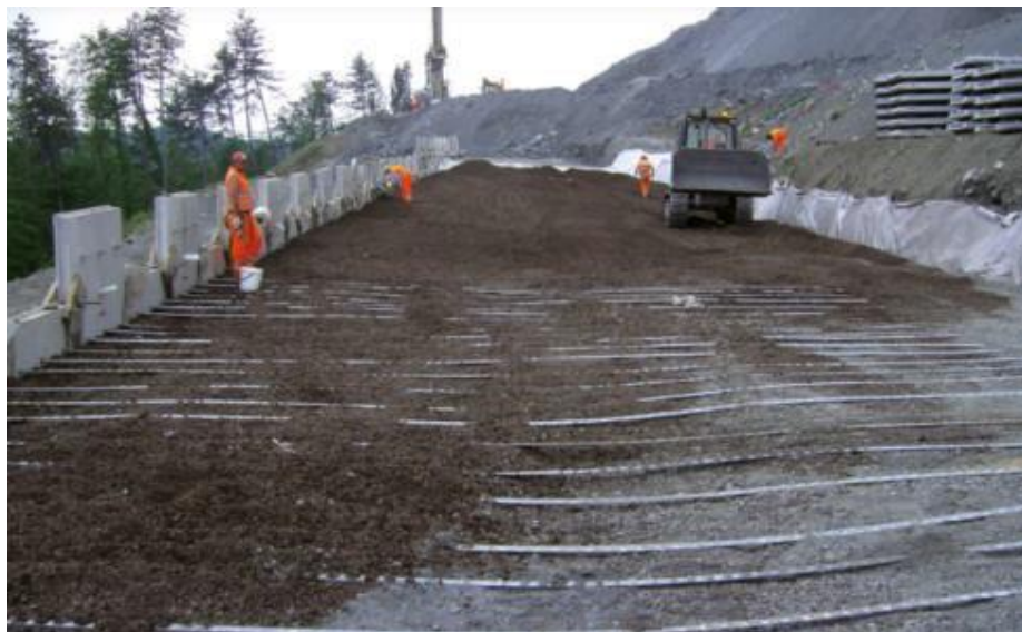
Figure II.8 Le renforcement d'un remblai
