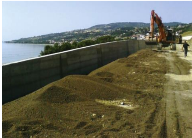
Figure II.3 Mise en œuvre d'un remblai contigu d'un ouvrage
