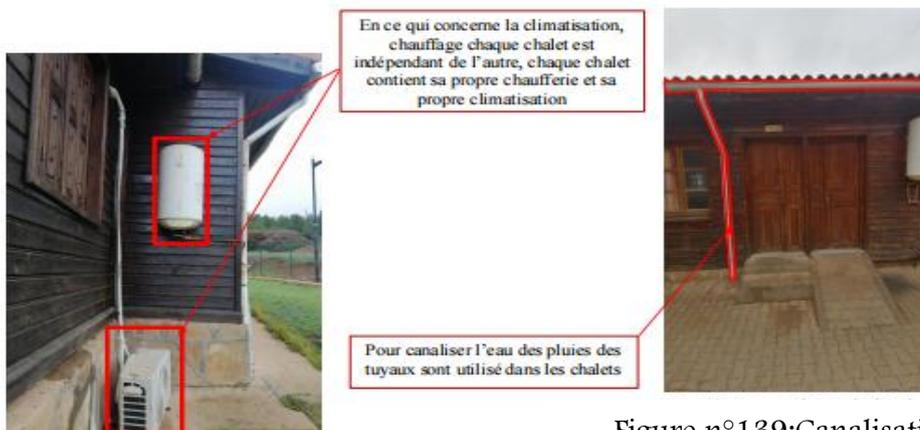
Figure n°138: Climatisation et chaufferie. Source: auteur.
