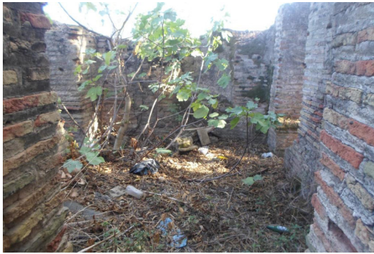
عينة عن استعمال الحجارة الغير منتظمة الزوايا (حمامات منزل متاهة المينوطور)
