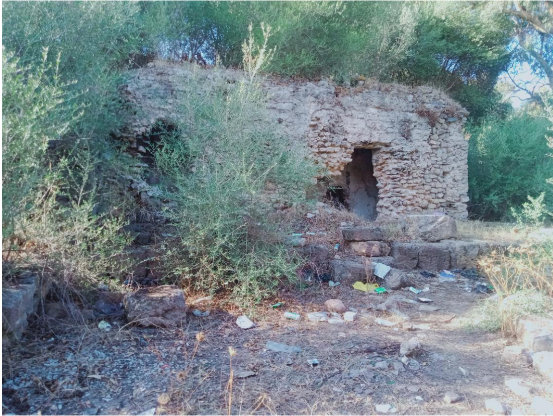
صورة رقم 03: خزانات منزل البروكوراتور (تصوير الطالبة)
