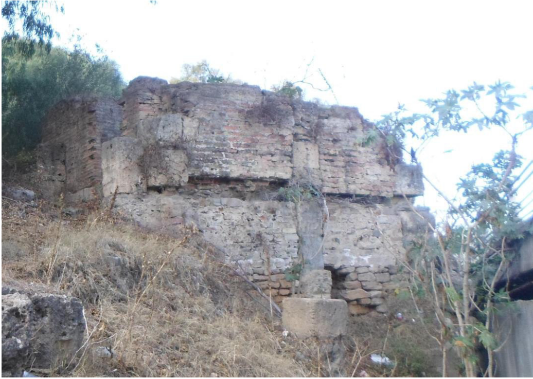
صورة رقم 12: التقنية الافريقية بحمامات البروكوراتور ( تصوير الطالبة)
