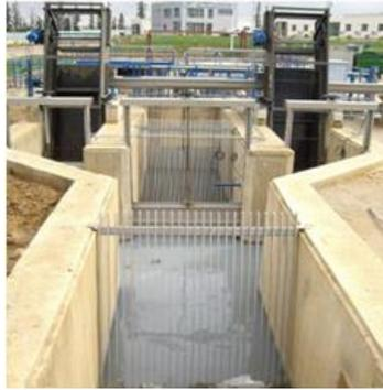
*Fig. 1. 3. Photos des dégrilleurs à l'entrée d'une station d'épuration*
