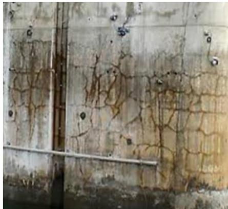
*Fig. 1.18. Fissures des ouvrages des STEP*
