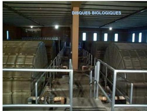
Fig. 1. 11 Photo de station à disque biologique
