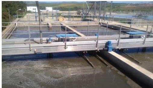
*Fig. 1. 4. Photo d'un dessableur – dégraisseur*
