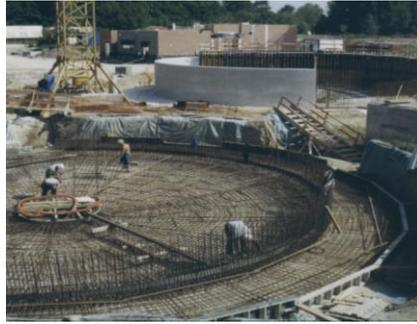
**Fig. 1. 15. Disposition des armatures en préparation du coulage d'un radier**
