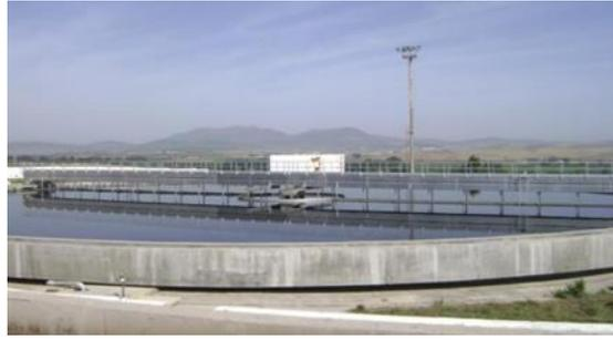
**Fig. 1. 13. Photo d'un clarificateur**
