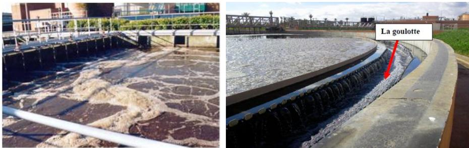
Fig. 1. 7. Photo illustrant le bassin d'aération biologique et le clarificateur
