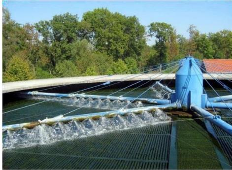
**Fig. 1.9. Photo d'une station à lit bactérien**
