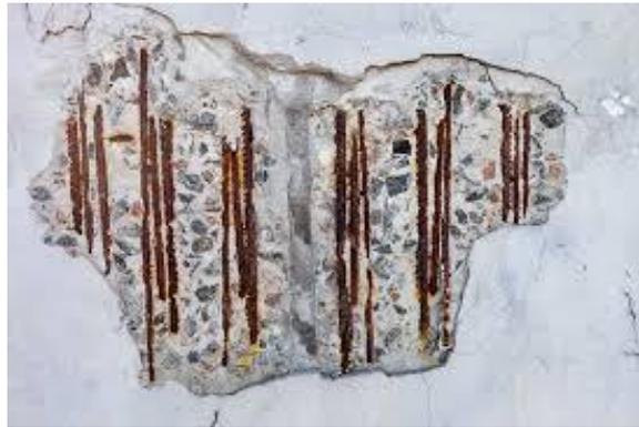
*Fig.1.19. Epaufrures et éclatement du béton due aux attaques chimiques*
