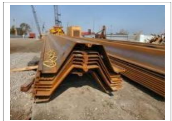
Figure IV.11. Murs de soutènements en palplanche métallique[35].
