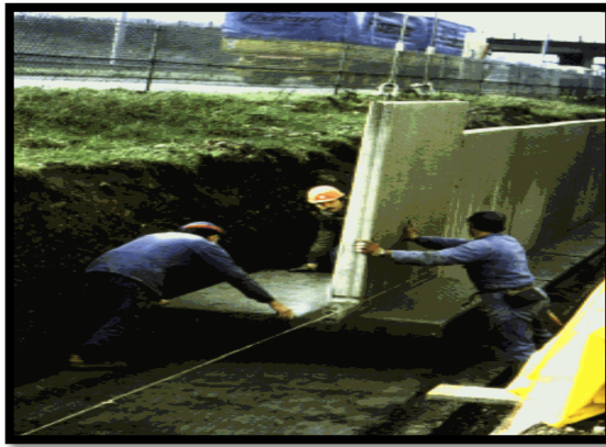
Figure IV. 7. Murs cantilever en béton armée contrefort
