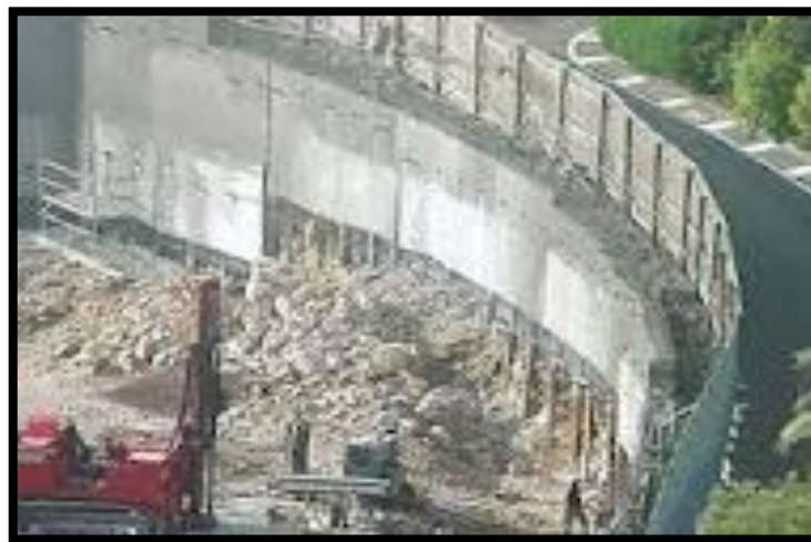
Figure IV.14. Mur de soutènement en paroi parisiennes[40].
