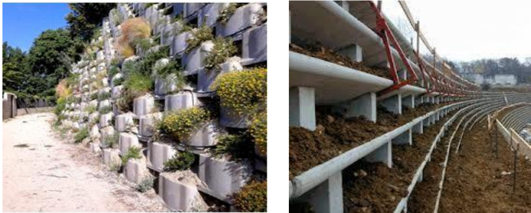
Figure IV.5. Murs poids en caisson [47].
