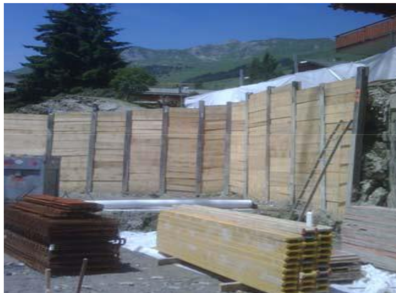
Figure IV. 12. Murs de soutènement en paroi berlinoise [35].
