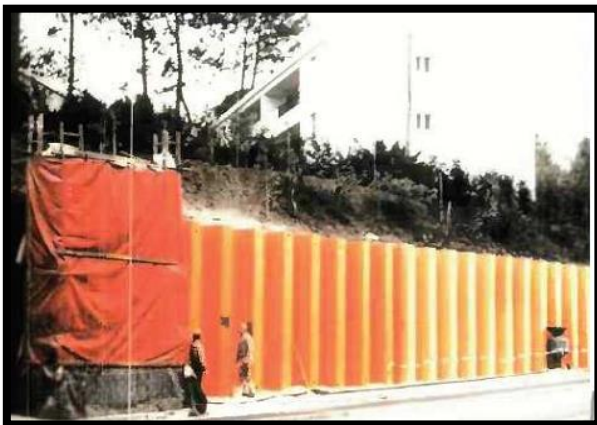
Figure IV.11. Murs de soutènements en palplanche métallique[35].
