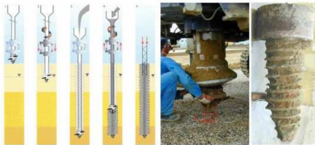
Figure III.6. Pieu vissé à pointe perdue Atlas.
