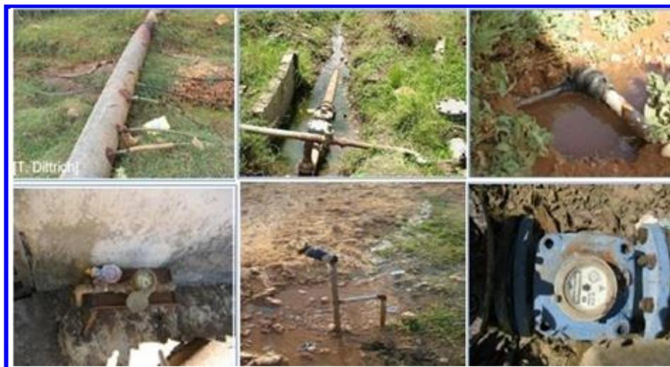
**Figure 1.17 : Les pertes d'eau apparentes**
