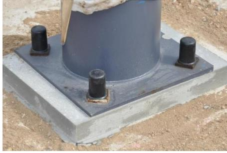
Figure IV.4. Calage d'un poteau en charpente métallique.
