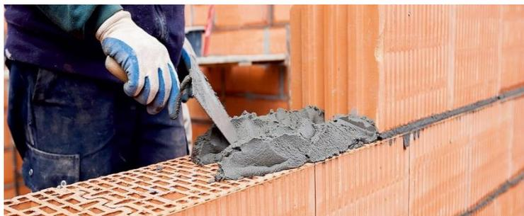
**Figure IV.1.** *Joints de maçonnerie.*
