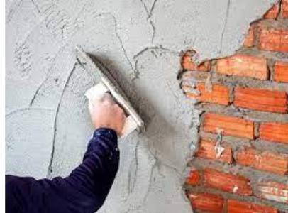
Figure IV.2. Application d'enduit.
