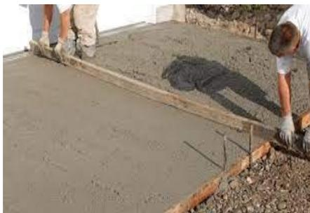
Figure IV.3. Application d'enduit pour chape.
