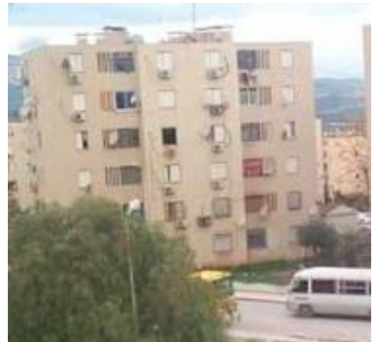
Fig.III. 28 exemple d'habitat collectif a Guelma (source : auteur prise le 02/11/2021)
