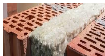
Fig.IV. 7 utilisation de la laine de roche a l'intérieur en lame d'aire( source : www.m-habitat.fr 12/05/2022)
