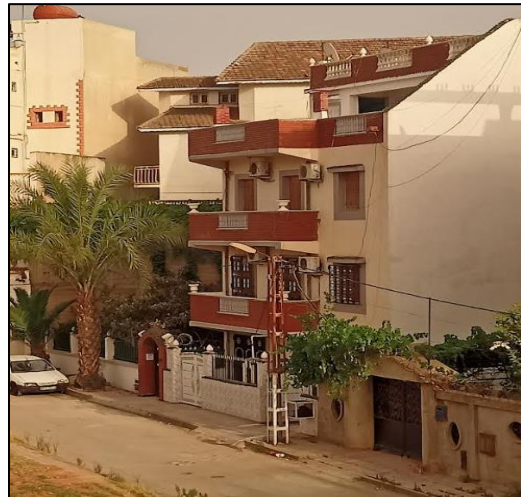
Fig.III. 30 Exemple d'habitat individuelle, Guelma ( source: auteur prise le 02/06/2022)
