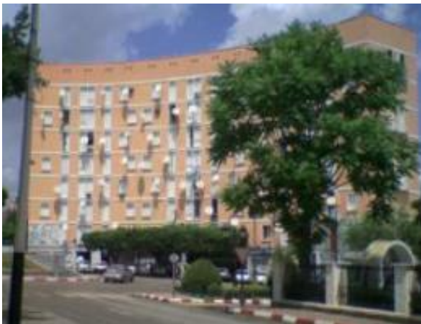
Fig.III. 27 Exemple d'habitat collectif a Guelma (source: auteur prise le 02/11/2021)
