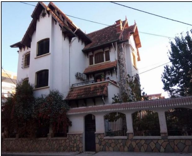
Fig.III. 29 Exemple d'habitat individuelle, Guelma ( source: auteur prise le 20/02/2019)
