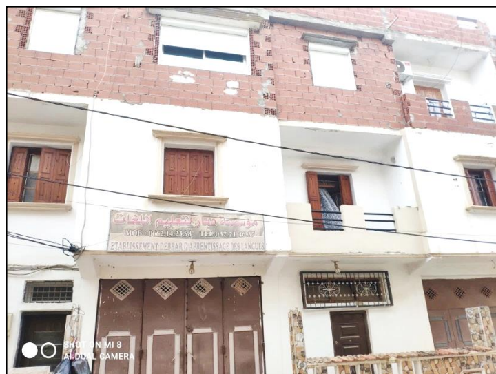
Fig.V. 18 façade principale ech 03 (source: auteur 2022)
