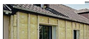
Fig.IV. 10 utilisation de la laine de roche a l'extérieur( source : www.m-habitat.fr 12/05/2022)
